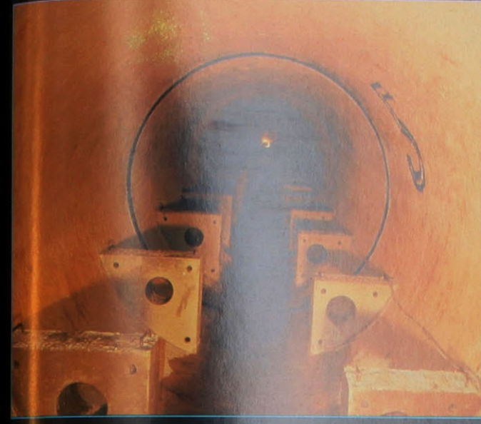
Pretláčanie chráničky pod riekou Váh v Hlohovci
