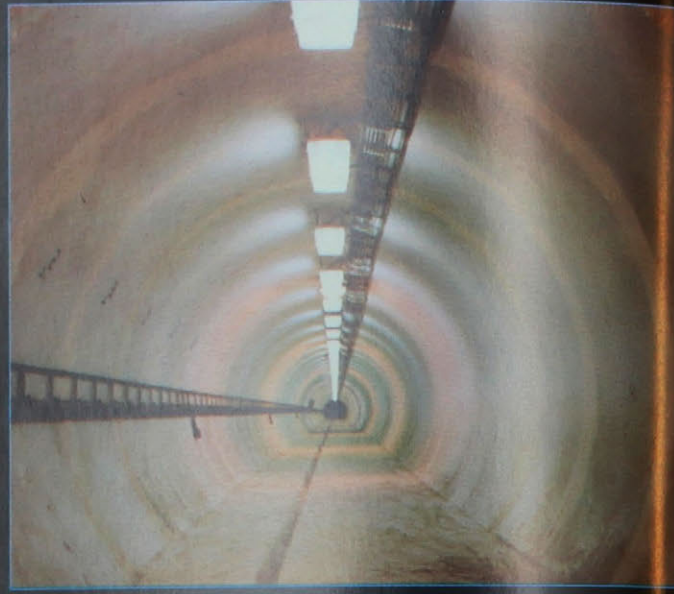
Pretláčanie krátkych veľkoprofilových rúr
