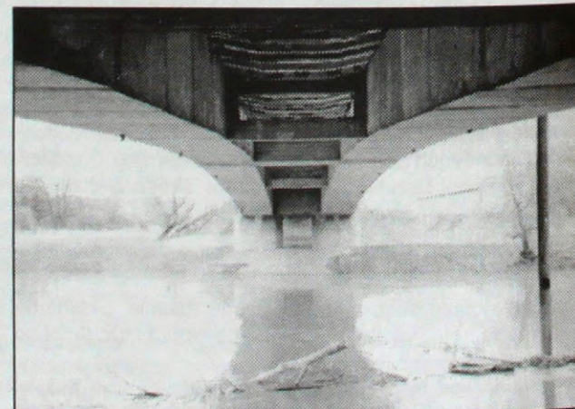
Obr. 3. Most v Sírniku – pohľad zdola na nosnú konštrukciu Fig. 3. Bridge in Sírnik – underview of the structure
