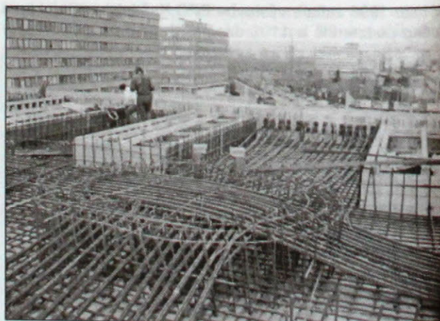
Obr. 12. Pohľad na predpínaciu výstuž premostujúceho roštu Fig. 12. A view to prestressing tendons of bridging grid
