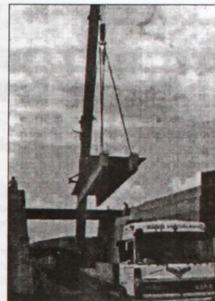
Obr. 5. Záber z montáže nosníkov TT DZ-97-15 na stavbe obj. 213 Nemšová-Ladce
