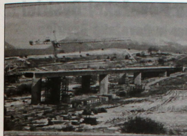
Obr. 2. Pohľad na most pred dokončením Fig. 2. View at the bridge before completing
