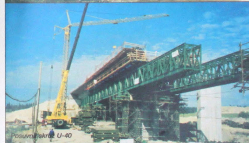
Betónová na posuvnej skruži
