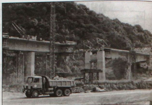
Obr. 4. Podpera „čakajúca“ na malý vozík Fig. 4. Support expecting travelling formwork
