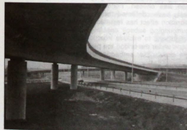
Obr. 1. Celkový pohľad na most Fig. 1. General view of the bridge
