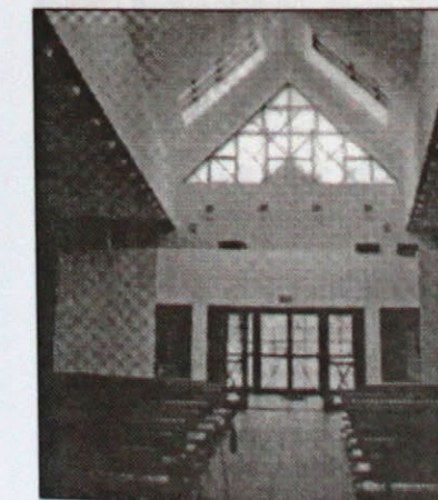
Obr. 3. Pohľad na strešnú konštrukciu chrámu – vstup Fig. 3. Church roof, partial view
