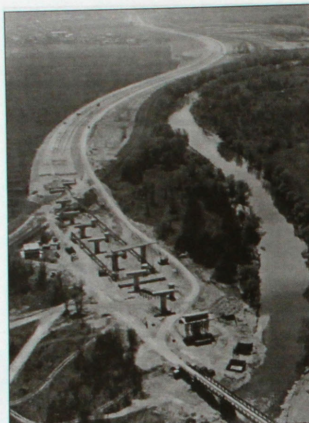
Obr. 2. Pohľad na stavenisko mosta Fig. 2. A view to a construction site
