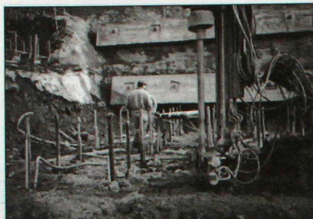
Obr. 3. Vrtanie mikropilót
