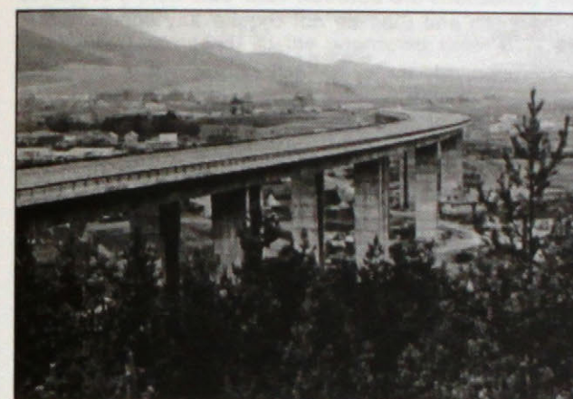
Obr. 1. Celkový pohľad na viadukt
