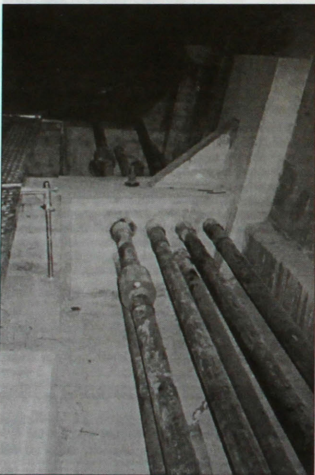
Obr. 15. Čelný pohľad na priečnik (deviátor) Fig. 15. Front view of a cross-beam (deviator)
