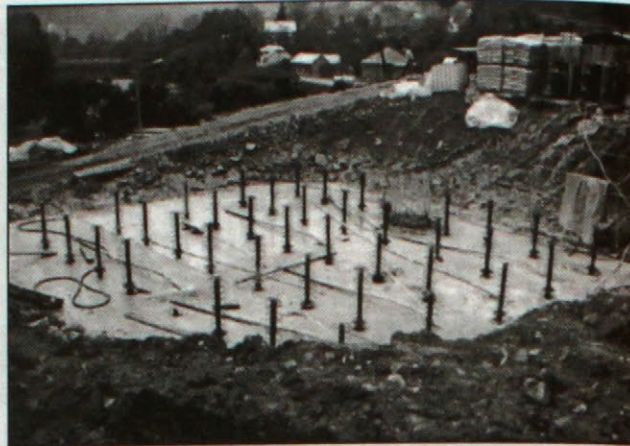
Obr. 4. Zakladanie mostných pilierov na mikropilóty
