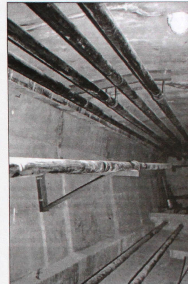
Obr. 12. Poloha káblov v poliach príslušných poľa s kĺbom Fig. 12. External cables layout in a span adjacent to that with expansion joint
