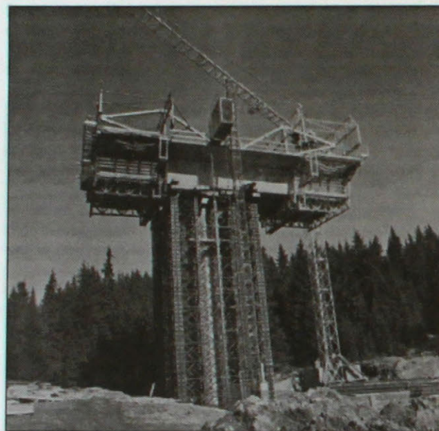
Obr. 1. Prvé nasadenie betónových vozíkov
