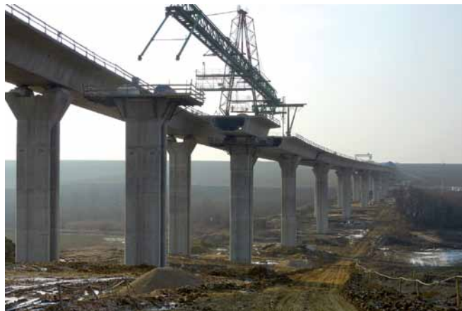
Obr. 4 Montáž nosnej konštrukcie Fig. 4 Erection of bridge superstructure
