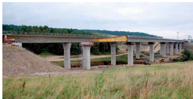
Obr. 4 Most na diaľnici nad Iľašovským potokom pri výsuvu Fig. 4 View of motorway bridge over the brook Iľašovský potok during launching
