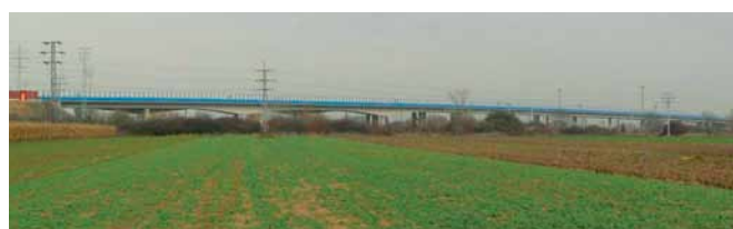
Obr. 1 Dokončený mostný objekt 206-00 Fig. 1 Completed bridge object 206-00
