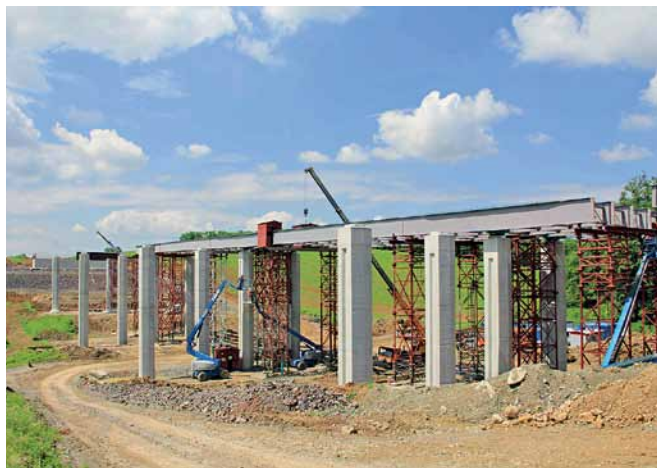
Obr. 7 Zväracia kabína na montážne spoje Fig. 7 A welding booth
