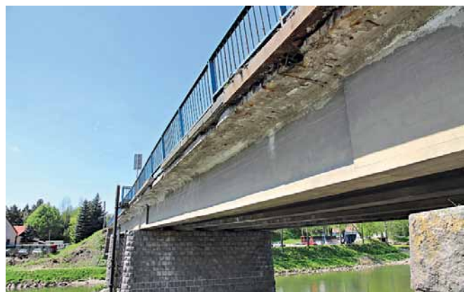
Pôvodný stav mosta Old state of the bridge
