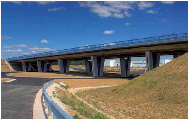
Mostný objekt 215 v križovatke Kechnec Structure 215 – bridge at the Kechnec interchange
