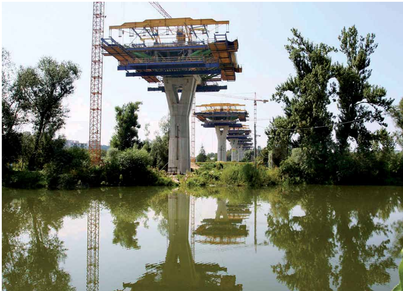
Obr. 6 Estakáda Považská Bystrica počas výstavby Fig. 6 The In-town Flyover in Považská Bystrica during construction
