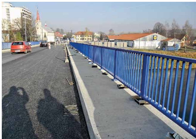
Pohľad na mostný zvršok pred dokončením View of the bridge superstructure before completion
