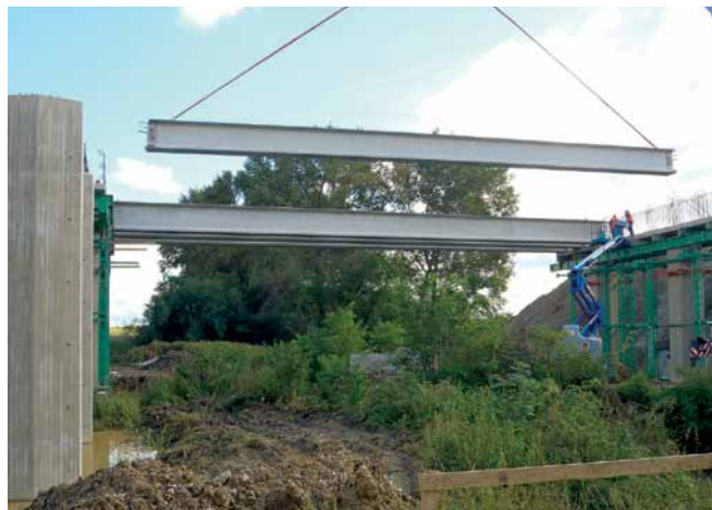
Obr. 6 Uloženie nosníkov na prefabrikované dosky Fig. 6 Placing the beams on precast panels
