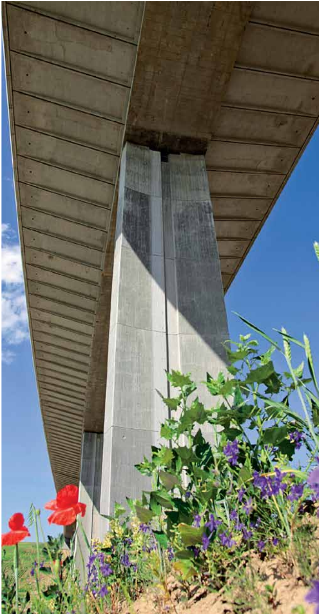
Obr. 12 Most přes údolí Hostovského potoka Fig. 12 Bridge across the Hostovsky Creek Valley
