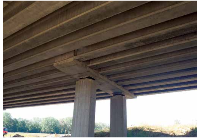
Obr. 8 Uloženie nosnej konštrukcie na ložiskách Fig. 8 To save the structure on bearings
