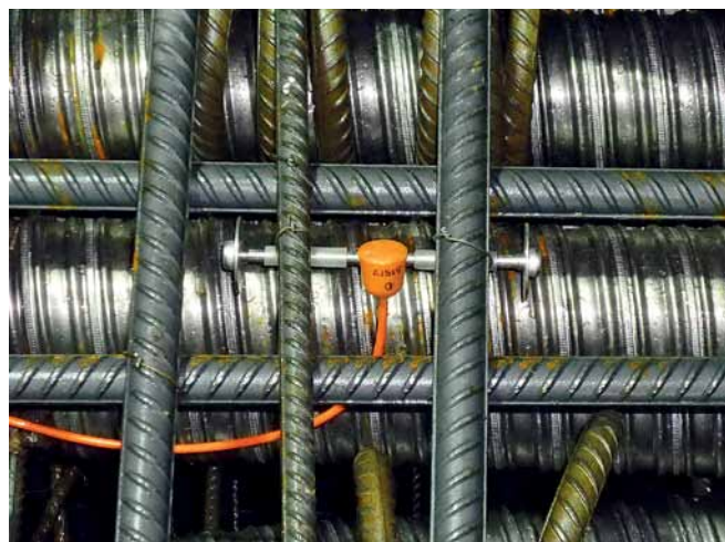
Obr. 2 Inštalácia snímača Fig. 2 The strain gauge arrangement
