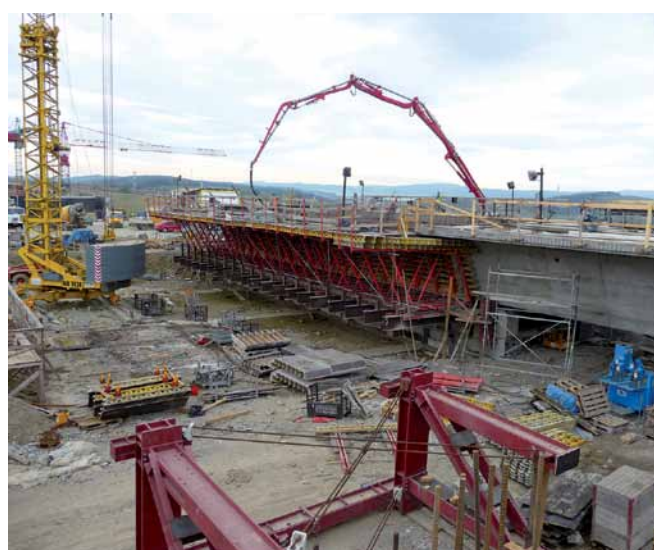
Výrobná lamiel za oporou 9 pravého mosta The segment factory situated behind abutment no. 9
