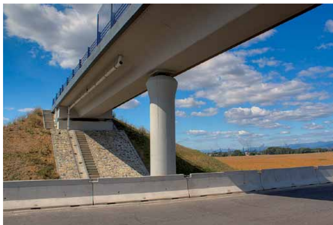
Mostný nadjazd na poľnej ceste Overbridge on field road
