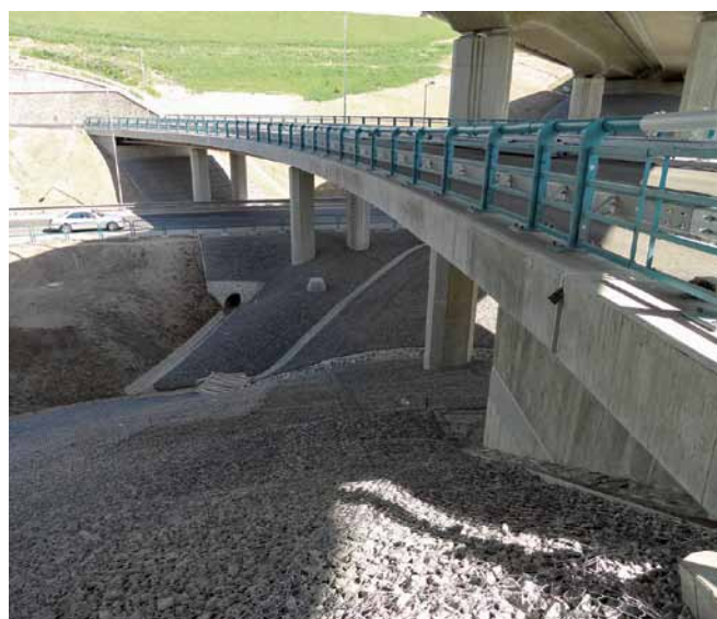
Obr. 10 Pohľad na most na vetve RUD A Fig. 10 Bridge view
