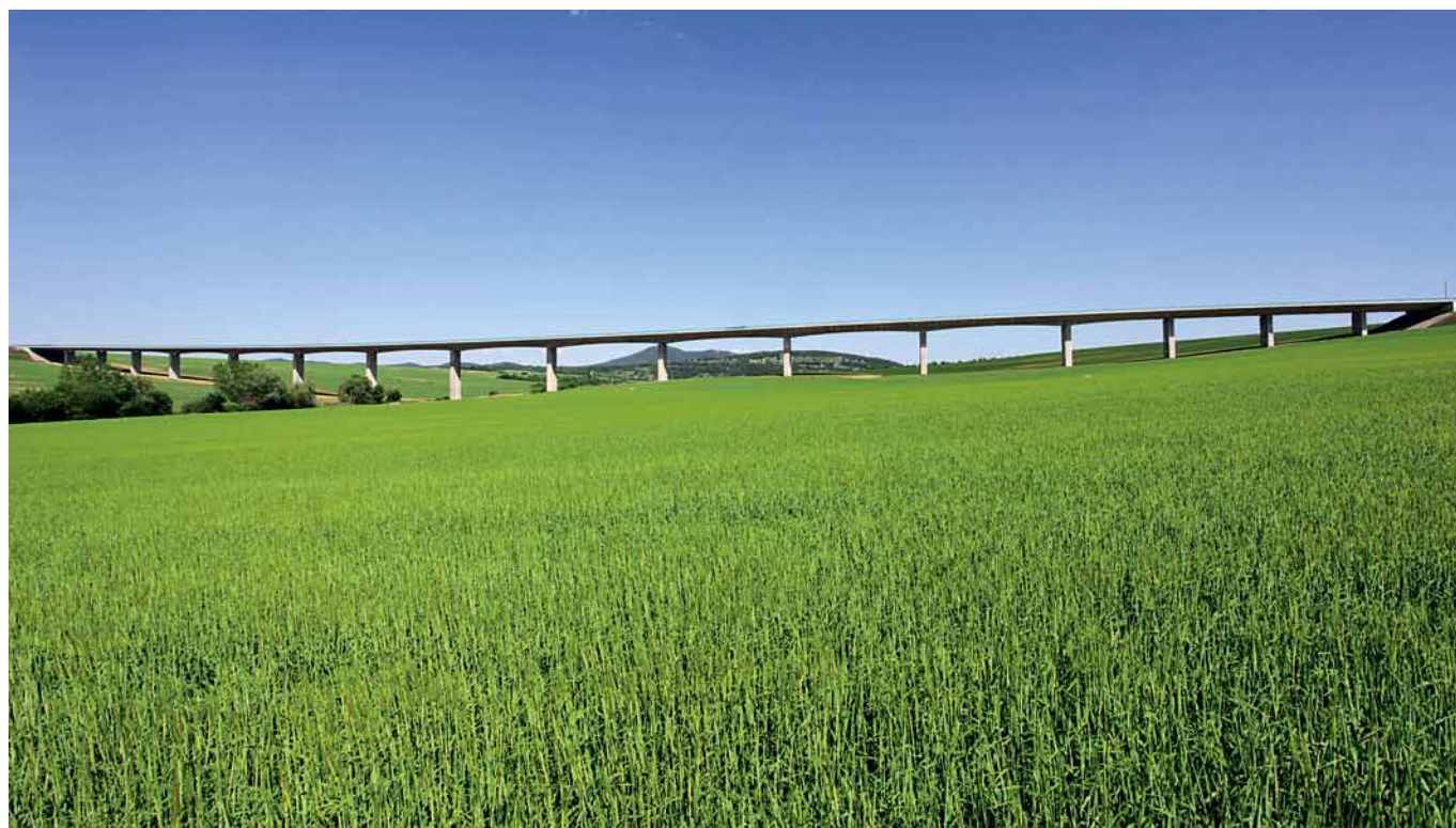
Obr. 1 Most přes údolí Hostovského potoka Fig. 1 Bridge across the Hostovsky Creek Valley
