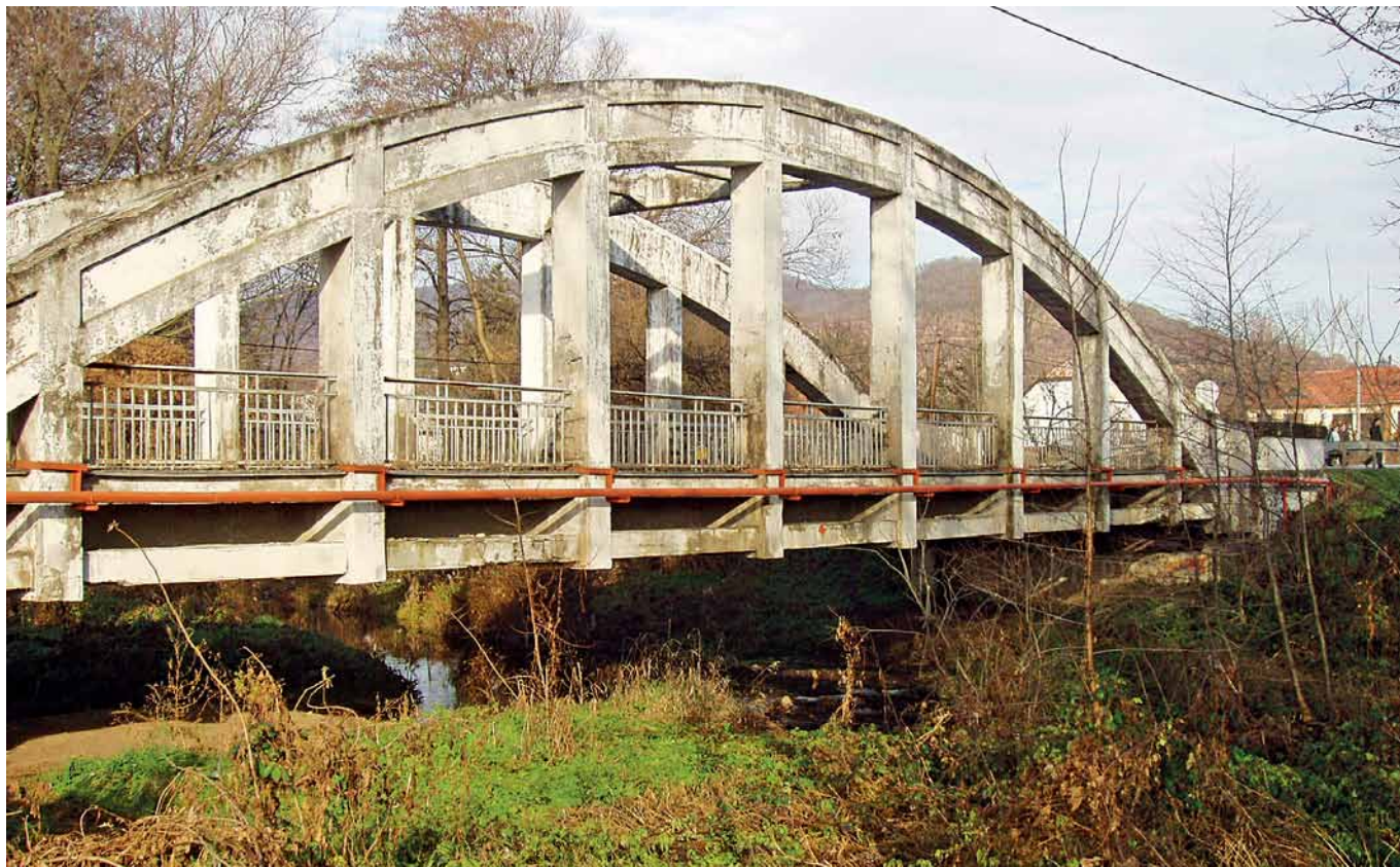
Stav mostného objektu v roku 2005
