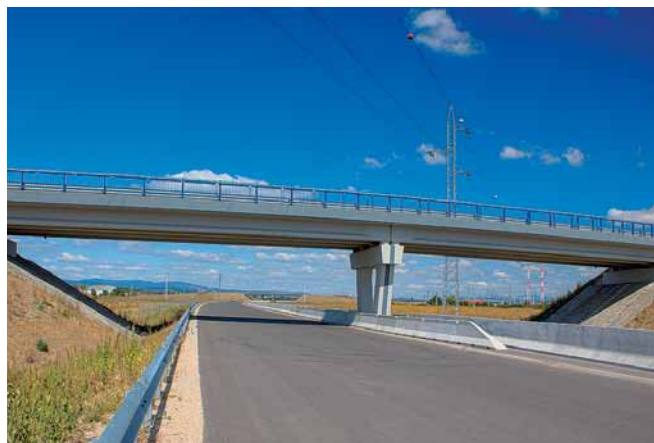
Mostný nadjazd z predpätých tyčových prefabrikátov Overbridge of prestressed precast girders
