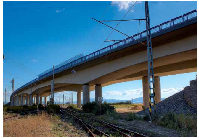
Mostný objekt 206 Bridge structure 206
