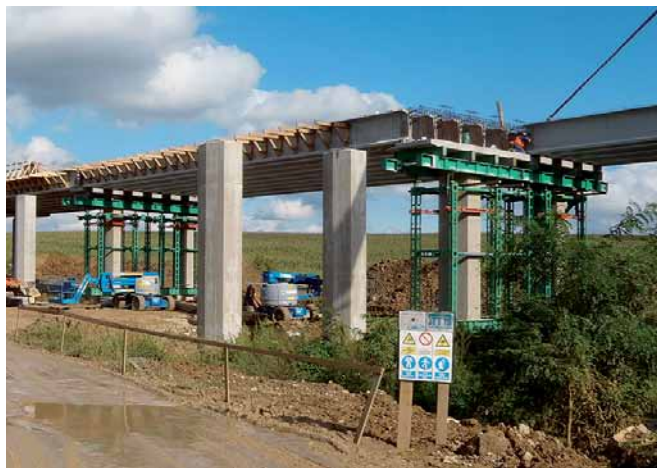
Obr. 5 Montáž nosníkov Fig. 5 Installation of beams
