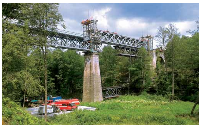
Spuštění dílů staré konstrukce
