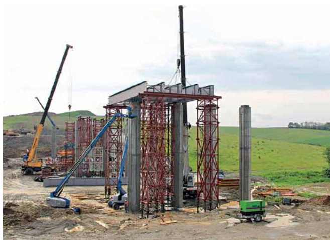
Obr. 5 Zárodok oceľovej konštrukcie mosta Fig. 5 Bridge deck starter
