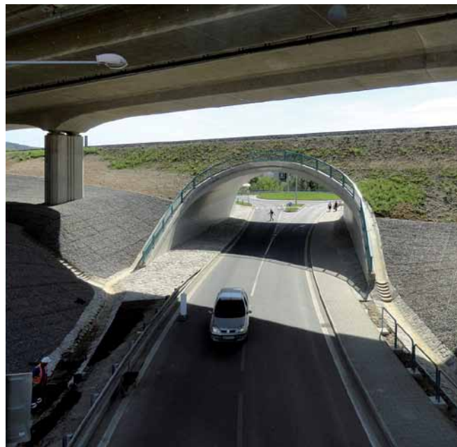
Obr. 13 Pohľad na klenbový most Fig. 13 View of the culvert
