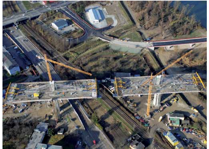
Obr. 9 Vozíky letmej betonáže Fig. 9 Concreting form-travellers
