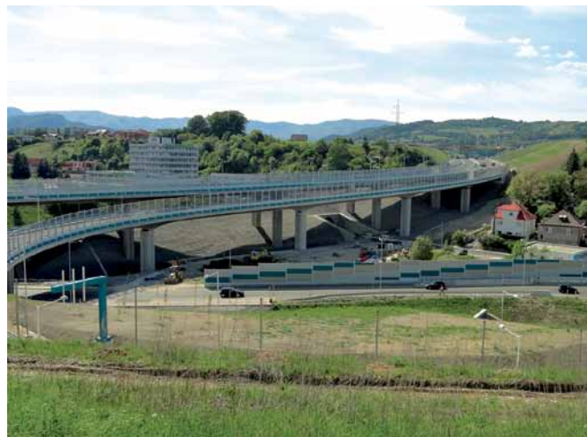
Obr. 7 Pohľad na most ponad novú a existujúcu komunikáciu Rudlová – Rudlovský potok – pohľad na most
