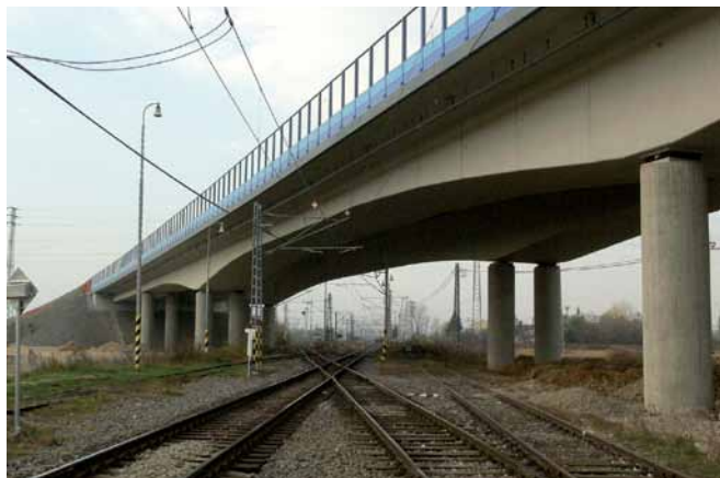
Obr. 2 Preklenutie širokorozchodnej železničnej trate mostným objektom 206-00 Fig. 2 Bridge object 206-00 bypass over the broad-gauge railway
