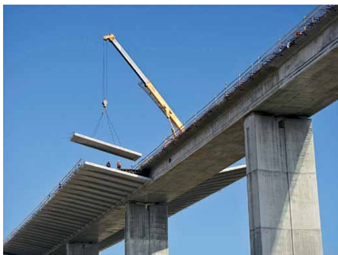
Obr. 10 Montáž prefabrikovaných vzpěr Fig. 10 Erection of the precast struts
