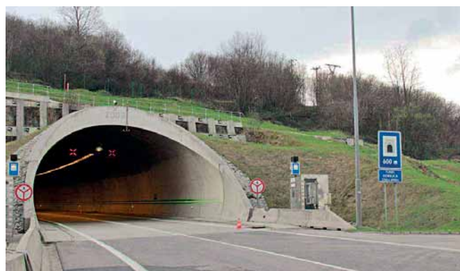
Obr. 1 Pohľad na tunel Horelica Fig. 1 View of the Horelica tunnel
