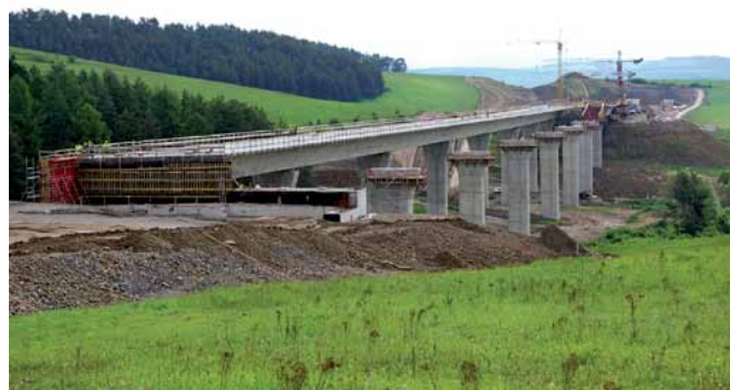
Výstavba mosta 205-00 The bridge construction
