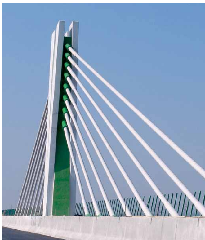
Obr. 14 Estakáda Považská Bystrica počas prevádzky – pylón s ED káblami Fig. 14 The In-town Flyover in Považská Bystrica – pylon with extradosed cables
