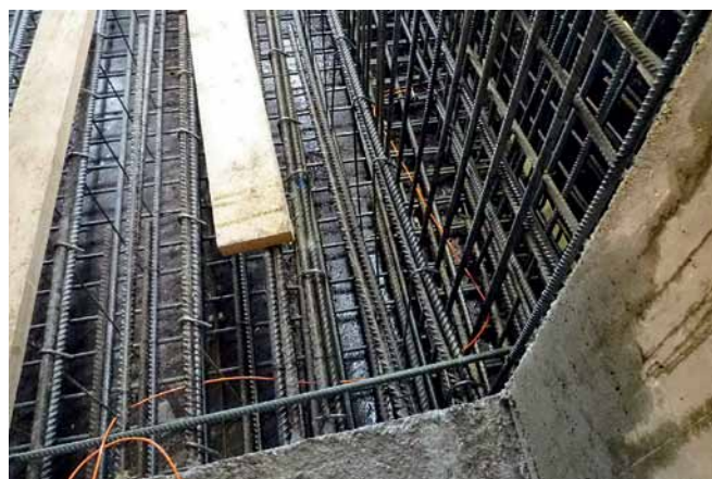
Obr. 7b Inštalácia snímačov Fig. 7b The sensors installation
