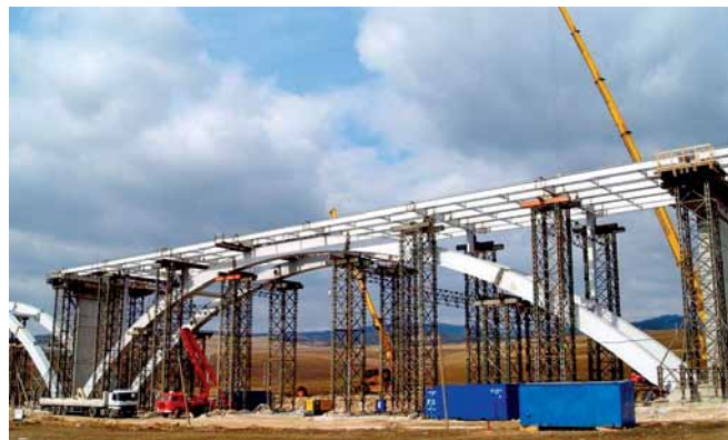
Obr. 3 Montáž oceľovej konštrukcie
