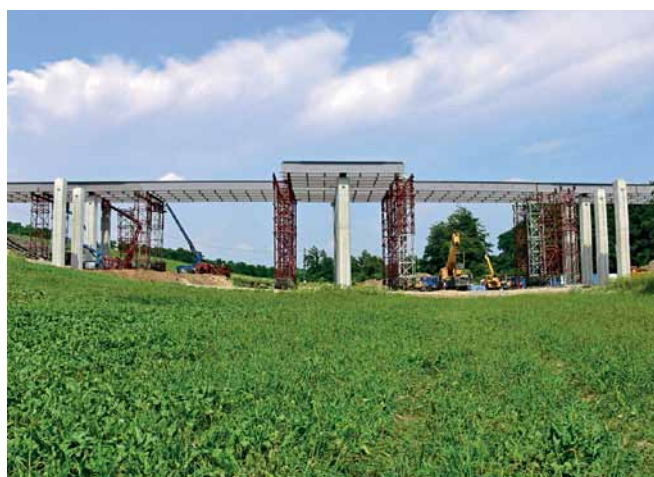
Obr. 6 Kompletná oceľová konštrukcia ľavého a zárodok pravého mosta Fig. 6 Completed left bridge steelwork and starter of steelwork of the right bridge
