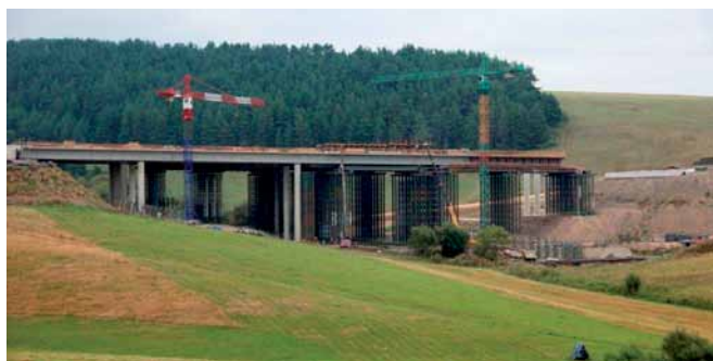
Obr. 5 Podporná konštrukcia mosta nad bezmenným potokom Fig. 5 View of support structure of the motorway bridge over the unnamed brook
