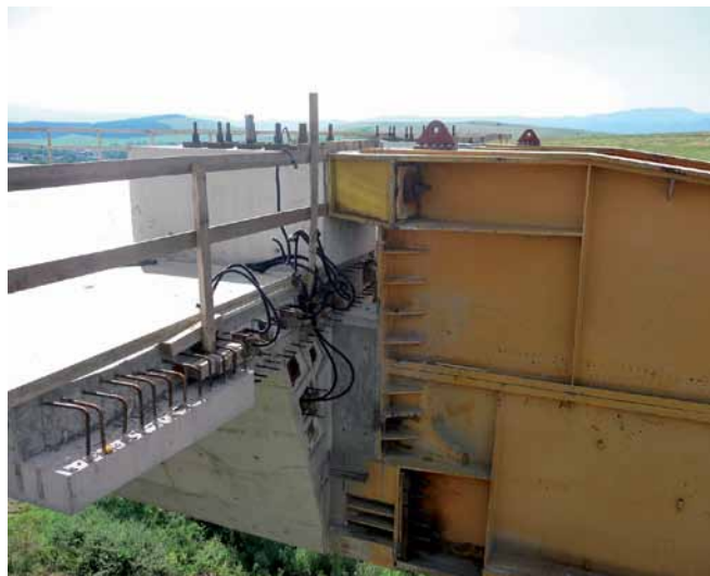
Pripojenie výsuvného nástavca na lamelu 1 The connection of launching "nose" on segment no. 1
