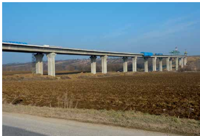
Obr. 5 Pohľad na most pred ukončením nosnej konštrukcie Fig. 5 View of the bridge before superstructure completion
