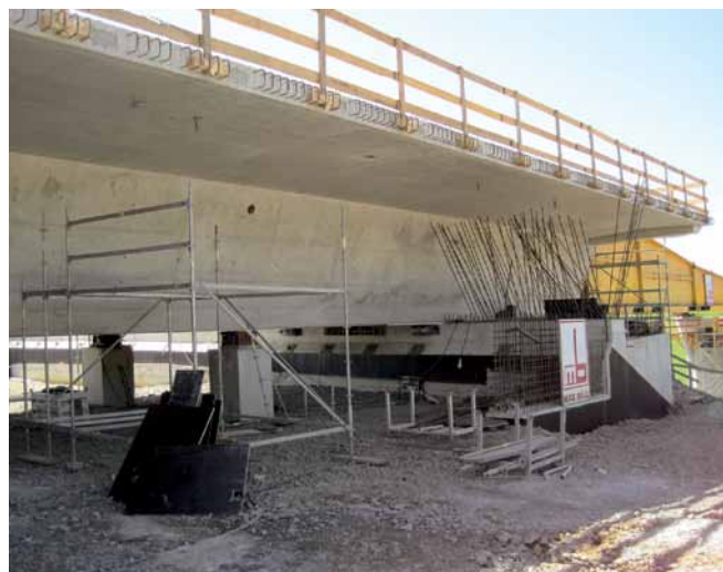
Opora 9 ľavého mosta Abutment no. 9 – left bridge
