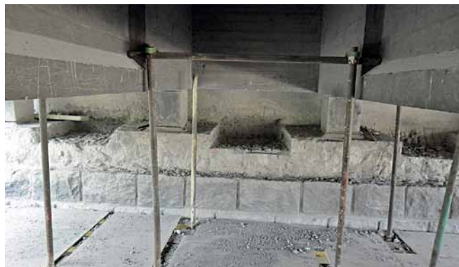
Vybúranie káps na betonáž úložných blokov pod lisy Removal of pockets for concreting of storage blocks below presses
