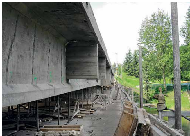
Dobetónovanie priečných stužovadiel Concreting of cross bracings
