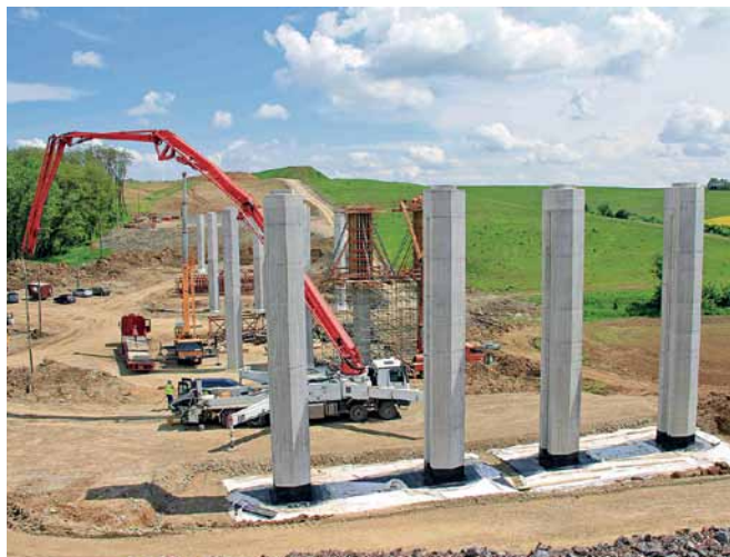
Obr. 3 Výstavba pilierov Fig. 3 Piers construction
