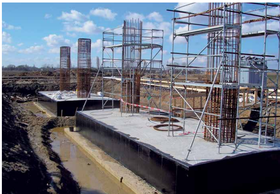
Zabetónované pätky pod budúcimi stĺpmi mosta.
