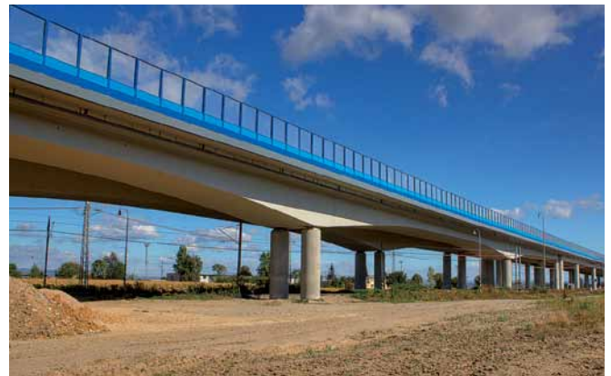
Pohľad na mostný objekt 206 View of bridge 206
