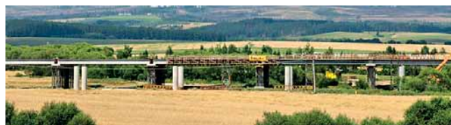
Obr. 1 Mostná estakáda na diaľnici D1 pri meste Poprad z predpätých nosníkov DPS-VP-I04
