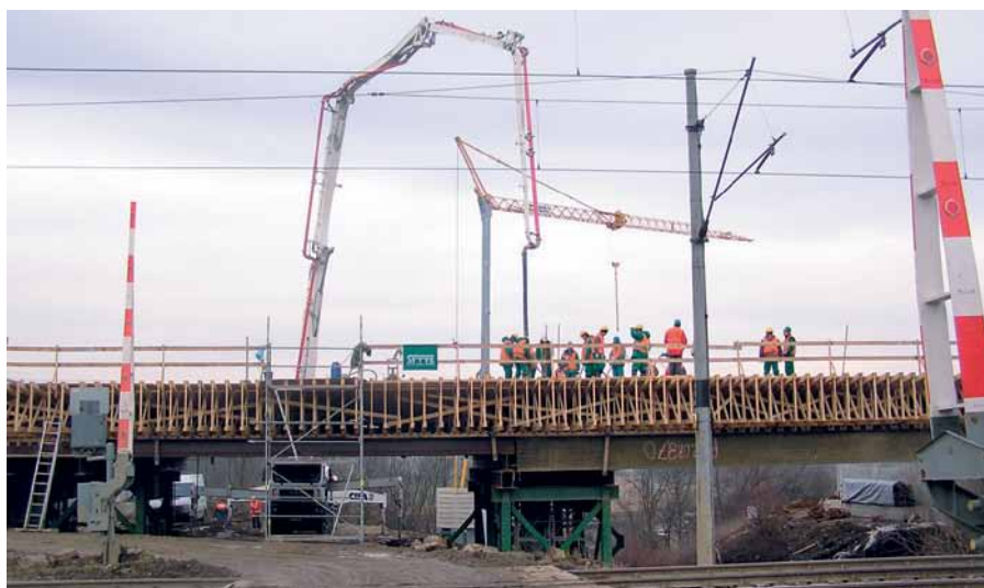
Väčšina betonáží si vyžadovala čerpanie betónu čerpadlami.
