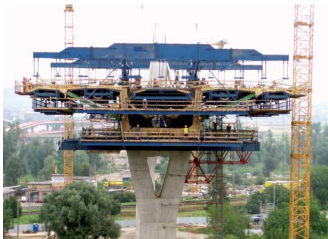
Obr. 7 Z výstavby Fig. 7 Bridge construction
