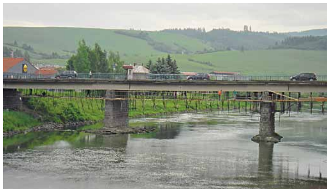
Závěsné lešení nad Oravou Hanging scaffolding over Orava
