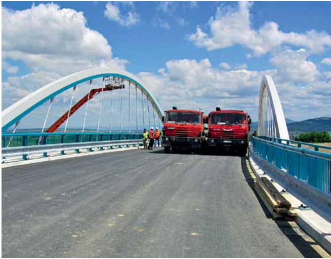
Obr. 9 Zatěžovací zkouška Fig. 9 Loading test
