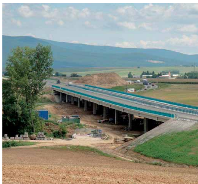
Obr. 1 Celkový pohľad na most Fig. 1 General view of the bridge
