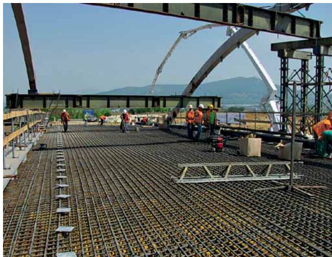
Obr. 7 Betonárska výztuž mostovky Fig. 7 Deck's reinforcing steel
