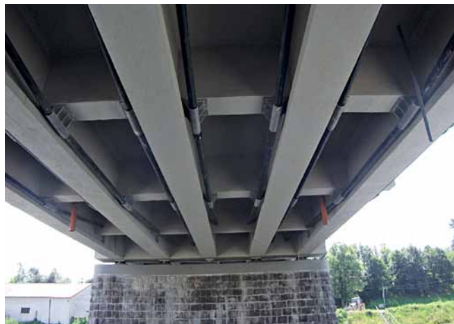
Pohľad na voľné káble predpätia View of the loose cables of bias
