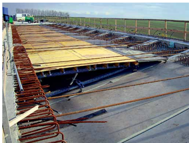
Obr. 11 Bednění vnějších konzol Fig. 11 Formwork of the overhangs
