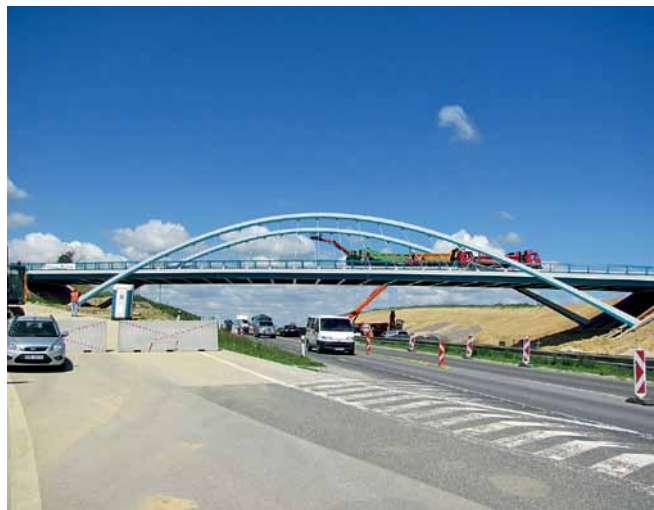
Obr. 8 Zatěžovací zkouška Fig. 8 Loading test
