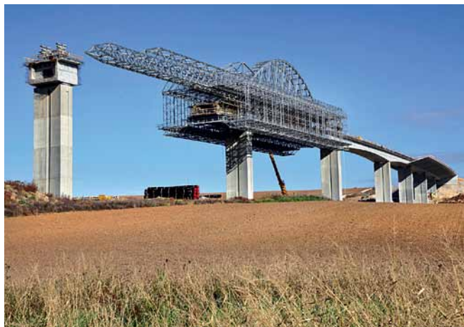
Obr. 7 Postupná výstavba mostu Fig. 7 Progressive construction of the bridge
