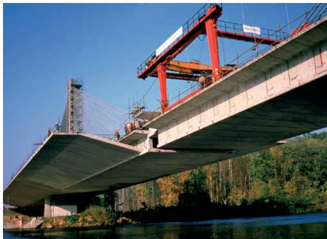
Obr. 1 Montáž mostu přes Labe u Poděbrad
