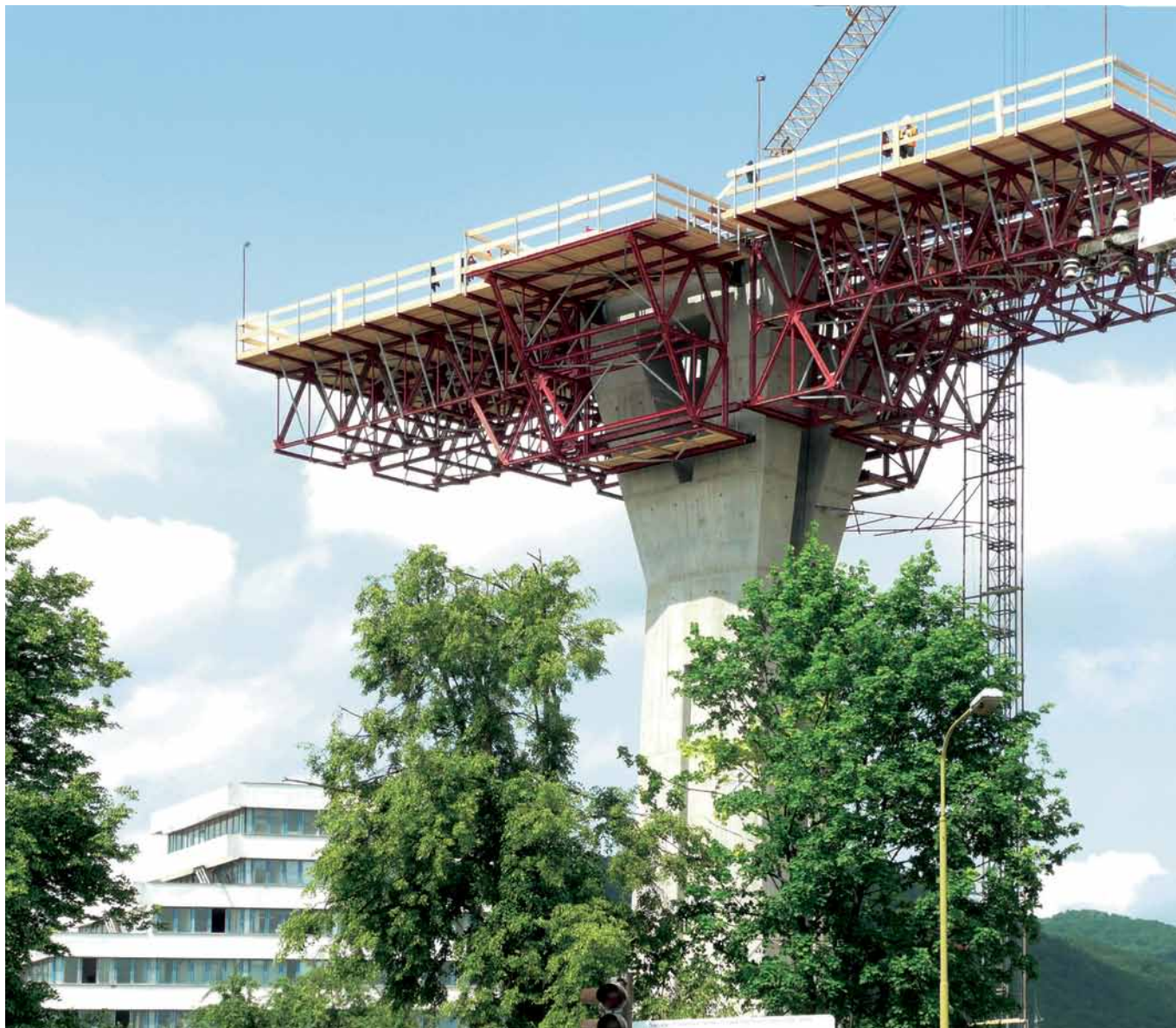
Obr. 5 Příprava debnenia zárodku Fig. 5 Prepare of the hammerhead formwork
