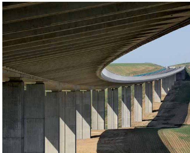
Obr. 18 Most přes údolí Hostovského potoka
