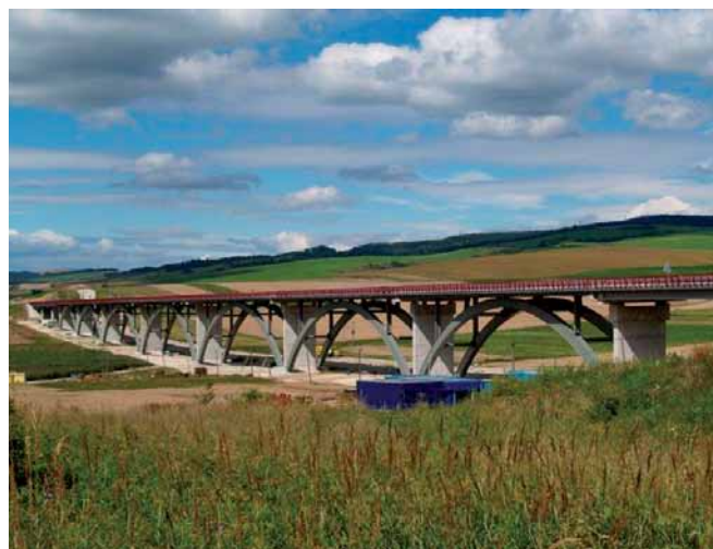
Obr. 4 Celkový pohľad na most
