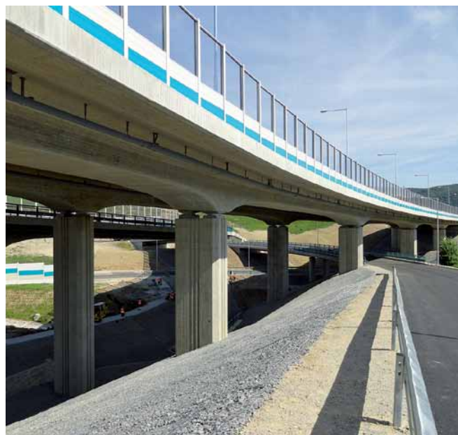
Obr. 4 Pohľad na most na R1 v km 1,606 629
