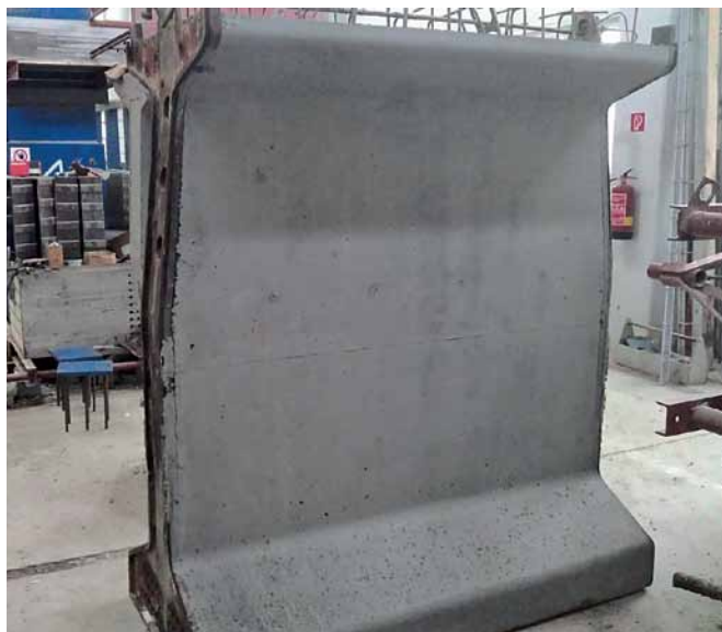
Obr. 3 Podhľad skúšobného segmentu č. 2 vyrobený z betónu C 80/95 XC4, XD3, XF2 Fig. 3 Bottom view of test segment No. 2 made of C 80/95 XC4, XD3, XF2 concrete
