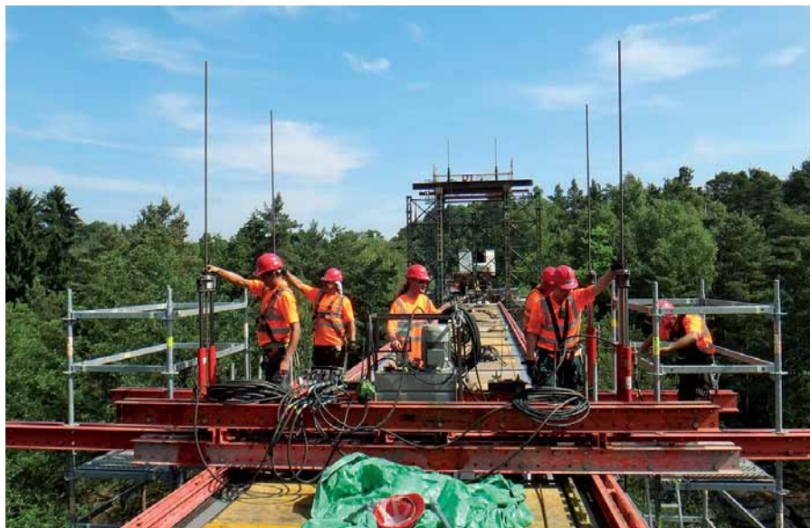
Vozík pro spouštění 4. a 5. dílu staré konstrukce
