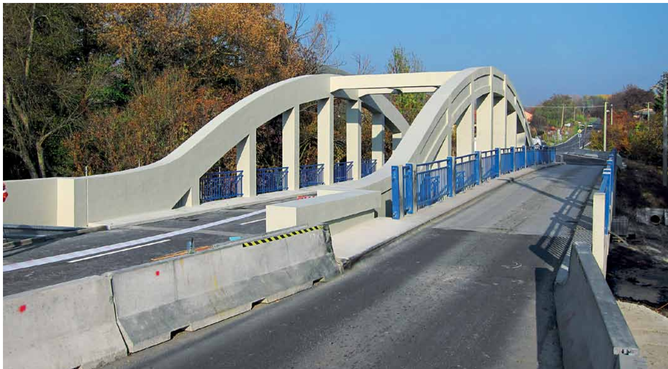
Pohľad na rekonštruovaný most tesne pred odovzdaním View to the reconstructed bridge just before handing
