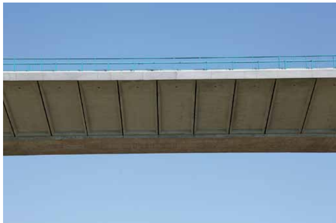
Obr. 8 Prefabrikované vzpěry Fig. 8 Precast struts
