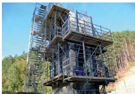
Výstavba II. diaľničného úseku D1 Jánovce – Jablonov vo východnej časti Slovenska na-
