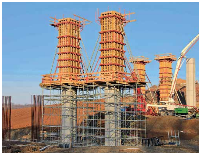
Obr. 4 Debnenie pilierov Fig. 4 Piers formwork
