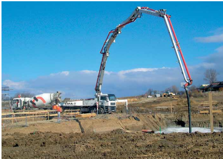
Betonáž na úseku Beladice – Tekovské Nemce.
