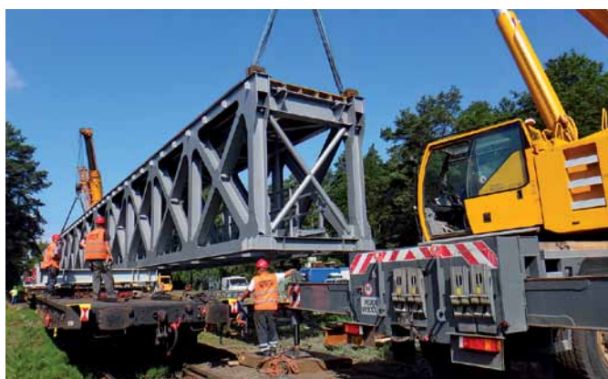
Nakládka nové nosné konstrukce na opleny
