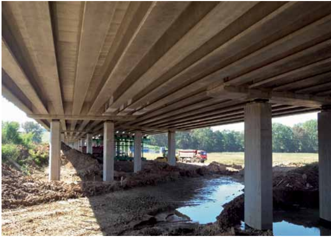
Obr. 7 Pohľad na nosnú konštrukciu s nosníkmi Fig. 7 View of the superstructure with beams
