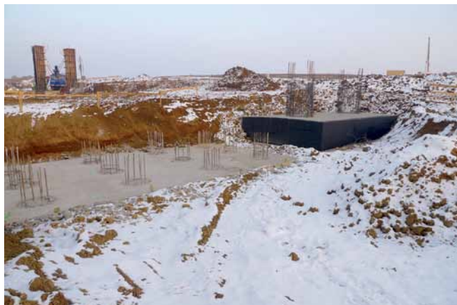
Obr. 2 Založenie pilierov na pilótach Fig. 2 The pier's pile foundation
