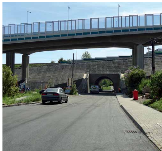
Obr. 16 Pohľad na most Fig. 16 View of the bridge
