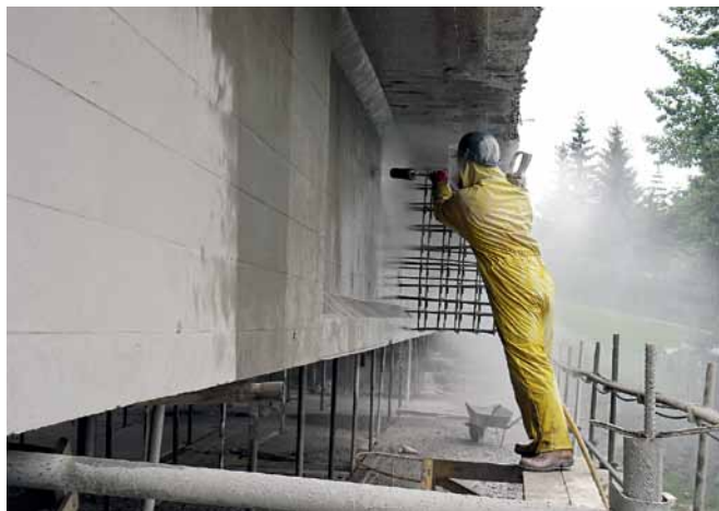
Abrázívne čistenie nosnej konštrukcie vodným lúčom Blasting of the structure with the waterjet
