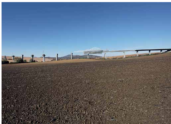
Obr. 9 Postupná výstavba mostu Fig. 9 Progressive construction of the bridge
