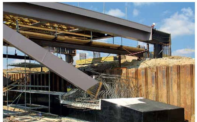
Obr. 6 Montážní podepření mostovky a oblouku Fig. 6 Erection support of the arch and deck
