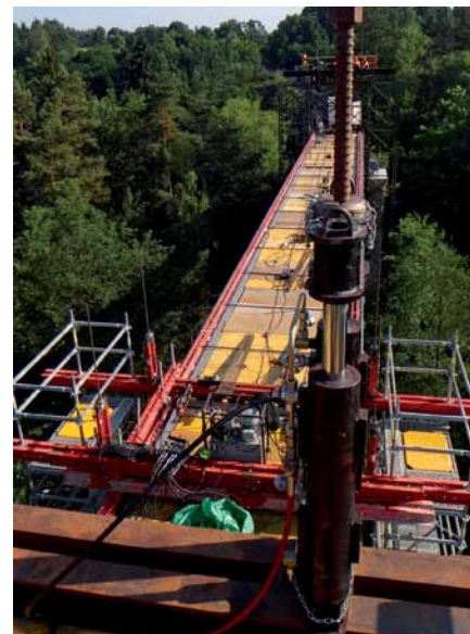
Pohled z portálu na pilíři na spouštěnou novou nosnou konstrukci
