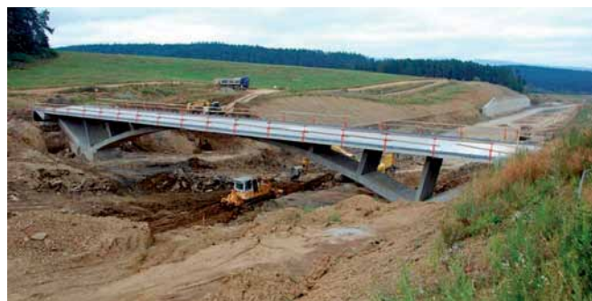
Obr. 6 Pohľad na železobetónový oblúk mosta nad diaľnicou na poľnej ceste Fig. 6 View of reinforced concrete arch bridge on the field road over the motorway
