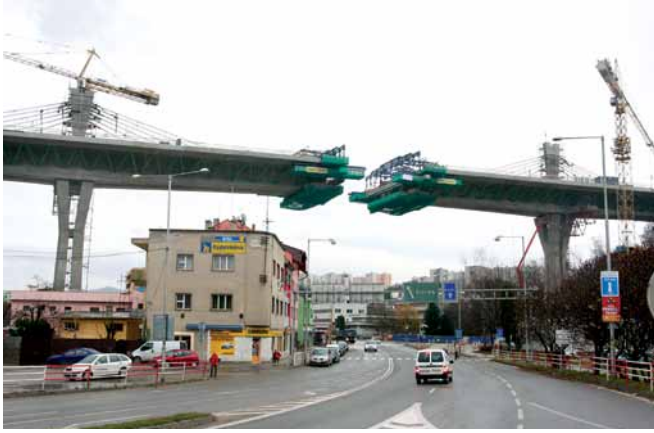
Obr. 8 Estakáda Považská Bystrica – mesto počas výstavby Fig. 8 The In-town Flyover in Považská Bystrica – the town during construction
