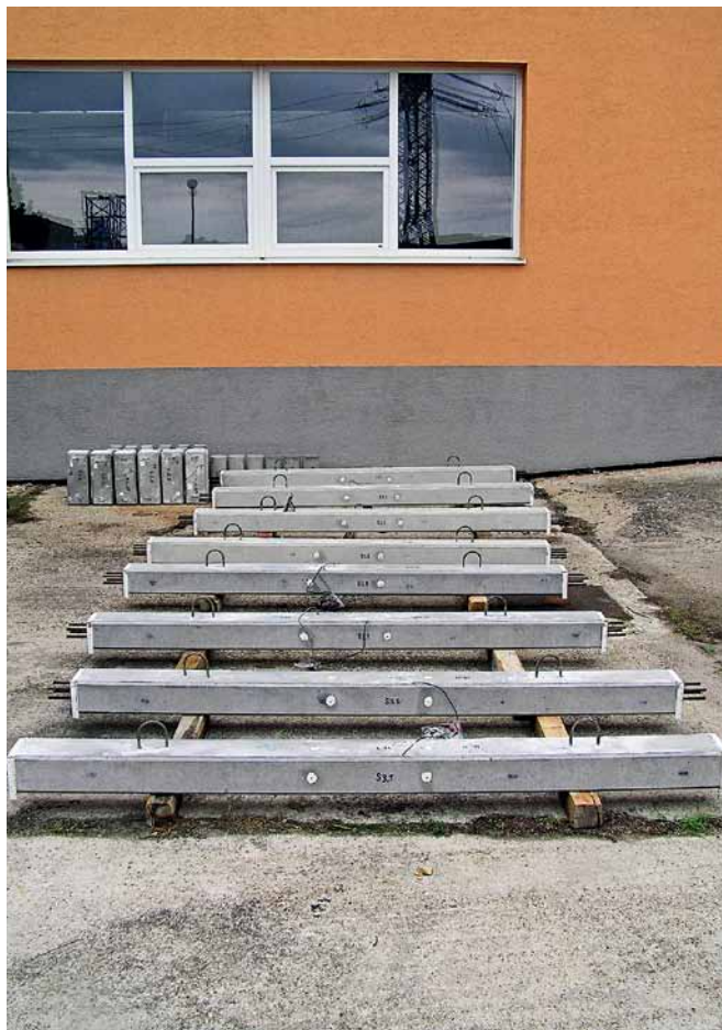
Obr. 2 Predpäté prefabrikované nosníky na skládke Fig. 2 Prestressed beams at the storage yard
