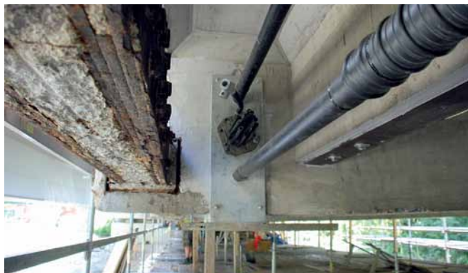
Pôvodné očistené ťahadlo, nové ťahadlo, nalepená oceľová pásnica Original, cleaned tie, new tie, bonded steel flange
