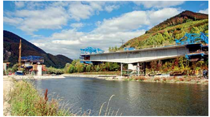
Obr. 2 Mostný objekt 201 Fig. 2 The bridge No. 201
