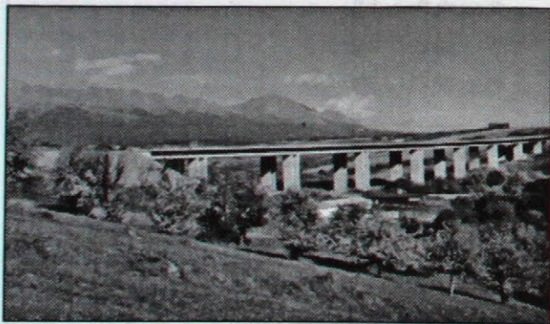
Obr. 1. Pohľad na dokončený most Hybica Fig. 1. Overall view of the completed Hybica Bridge
