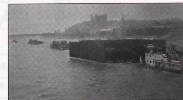
Obr. 4. Plavenie štetovnicovej ohrádzky do priestoru mosta Fig. 4. Floating in of the sheet wall to the right position
