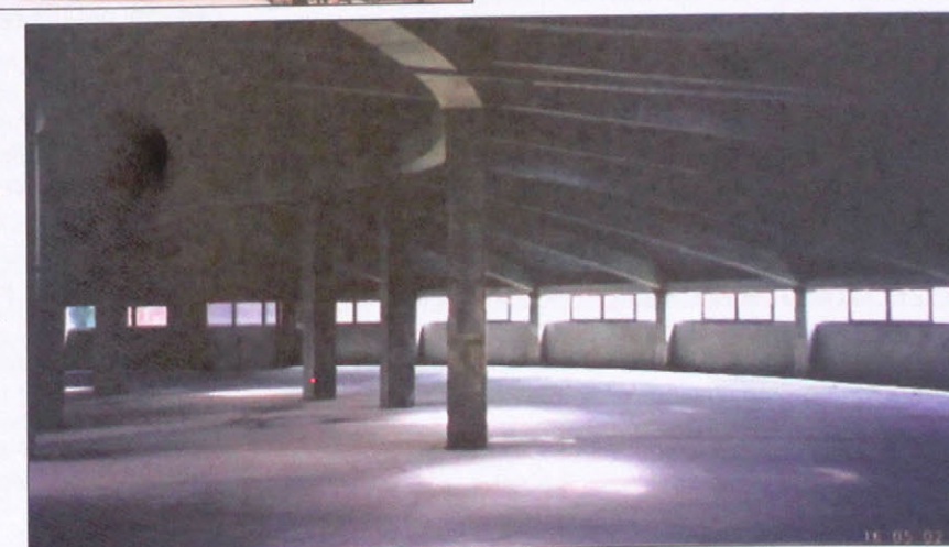
Obr. 8 Ineriér garáží - typické podlažie Fig. 8 Typical floor - Internal view
