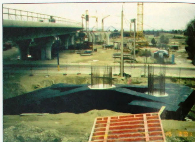
Obr. 3 Premostenie zberačov - realizácia Fig. 3 Bridging of main sewers - construction
