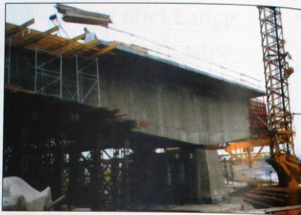
Obr. 2 Zárodok mosta nad podperou č.2 Fig. 2 Starter Section Above Pier 2
