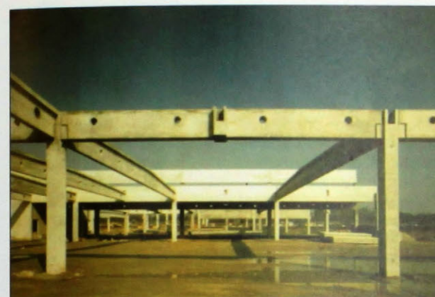
Obr. 14 Pozdĺžny pohľad na nosnú konštrukciu - Obchodné centrum Černý Most - Praha (Česká rep.) Fig. 14 Longitudinal view on the structure - Shopping centre of Černý Most - Prague (Czech rep.)
