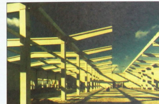
Obr. 17 Pohľad na nosnú konštrukciu - OBI - Šterboholý Praha (Česká rep.) Fig. 17 View on the structure - OBI - Šterboholý Praha (Czech rep.)
