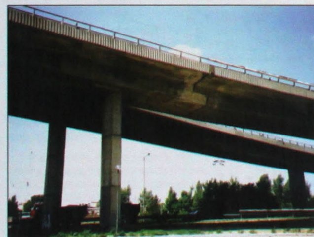
Obr. 7 Pohľad na zakotvenie šikmých tyčí a hotový ozub Fig. 7 View of completed strengthening
