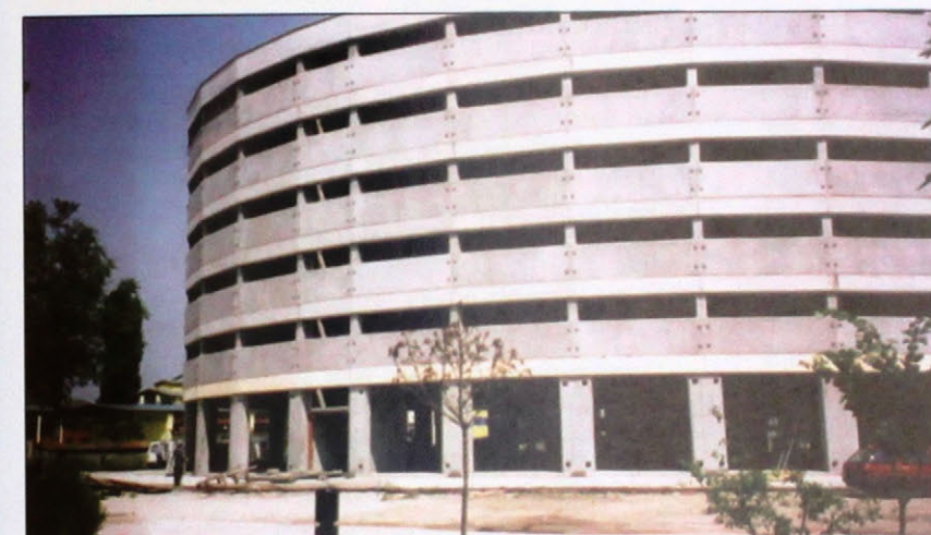
Obr. 7 Pohľad na hotovú konštrukciu Fig. 7 Car park - external view
