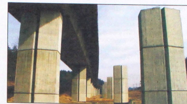
Obr. 2 Pohľad na rozostavaný most Fig. 2 Bridge under construction
