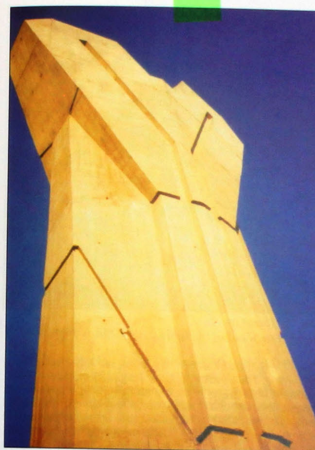
Obr. 3 Pohľad na rozostavanú podporu Fig. 3 View on the pier under construction
