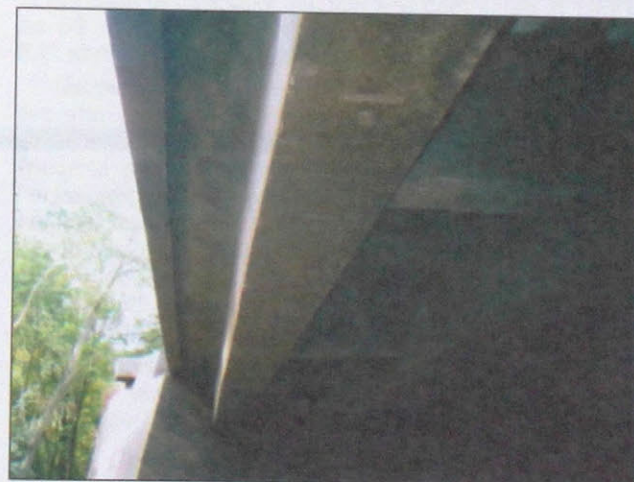
Obr. 4 Inštalovaná pásnica s finálnou povrchovou úpravou Fig. 4 Finished plate with final cover treatment
