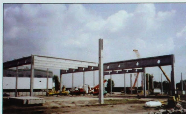
Obr. 9 Realizácia stavby - Škoda Auto, a.s. - Hala M6 - Mlada Boleslav (Česká rep.) Fig. 9 Construction of the hall - Škoda Auto, a.s. - Hall M6 - Mlada Boleslav (Czech rep.)
