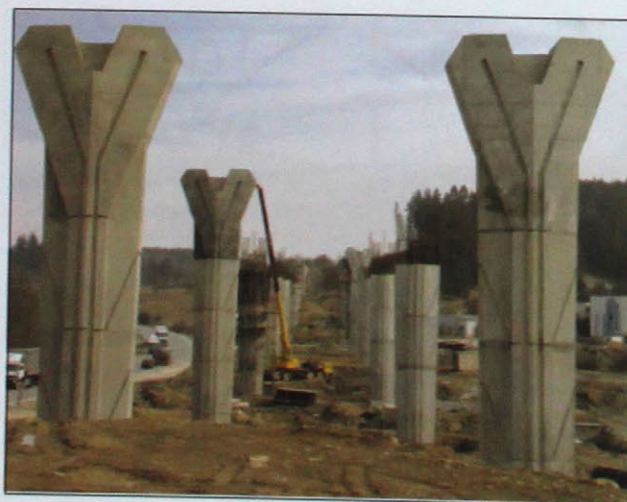
Obr. 5 Rozostavaná spodná stavba Fig. 5 Substructure under construction
