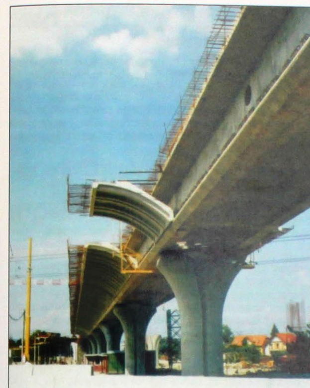
Obr. 5 Diaľničná estakáda vo výstavbe Fig. 5 The flyover under construction
