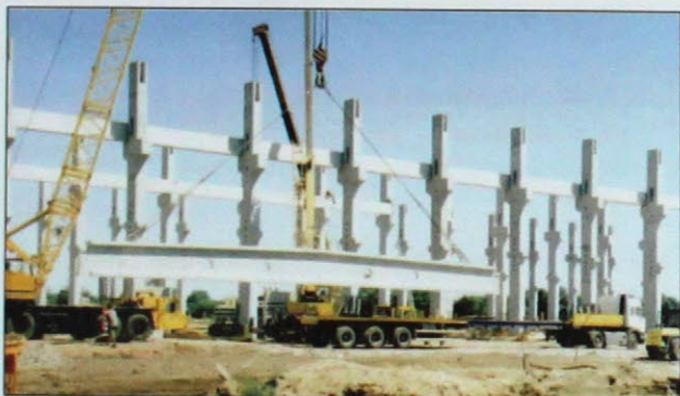
Obr. 10 Pozdĺžny pohľad - montáž väznika - Magdeburg (Nemecko) Fig. 10 Longitudinal view - erection of the girder - Magdeburg (Germany)
