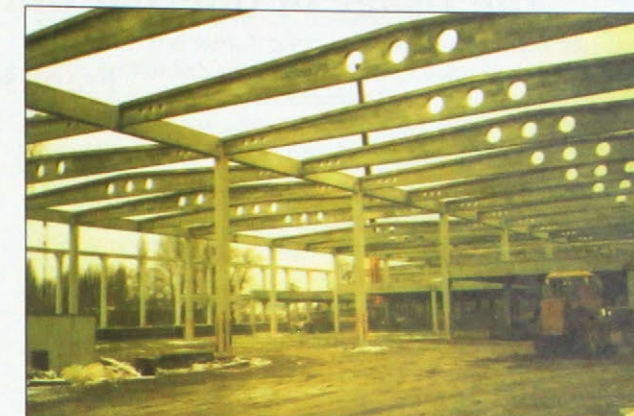
Obr. 15 Pohľad do haly na nosnú konštrukciu - IKEA - Brno (Česká rep.) Fig. 15 Inside the hall view on the structure - IKEA - Brno (Czech rep.)
