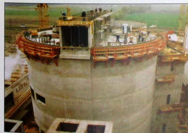
Obr. 2 Pohľad na konštrukciu síl kľúčiarne sladu počas výstavby,
