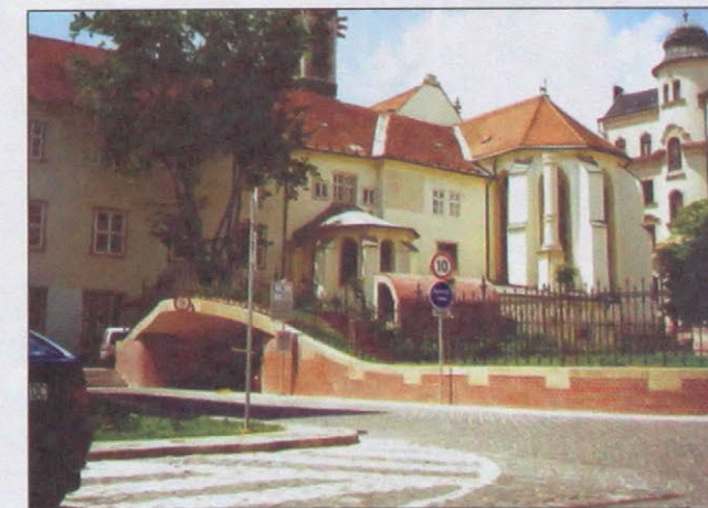
Obr. 3 Pohľad na vjazd do podzemných garáží po ukončení výstavby (foto: J. Mravec) Fig. 3 A sight at the underground garages' entrance when the construction has been finished (photo: J. Mravec)
