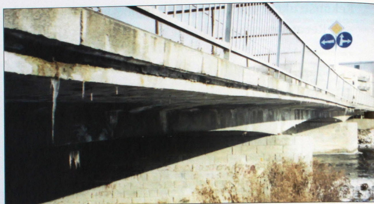
Obr. 1 Pohľad na most pred opravou Fig. 1 View of the bridge before reconstruction
