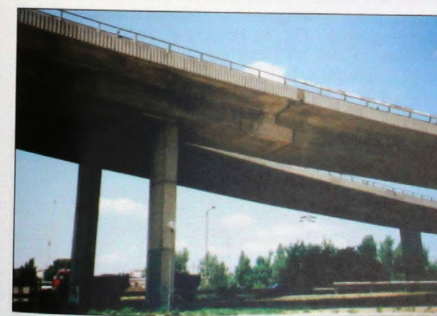
Obr. 1 Pohľad na ozub estakády Prístavného mosta Fig. 1 View of the Riverport bridge flyover stepped connection
