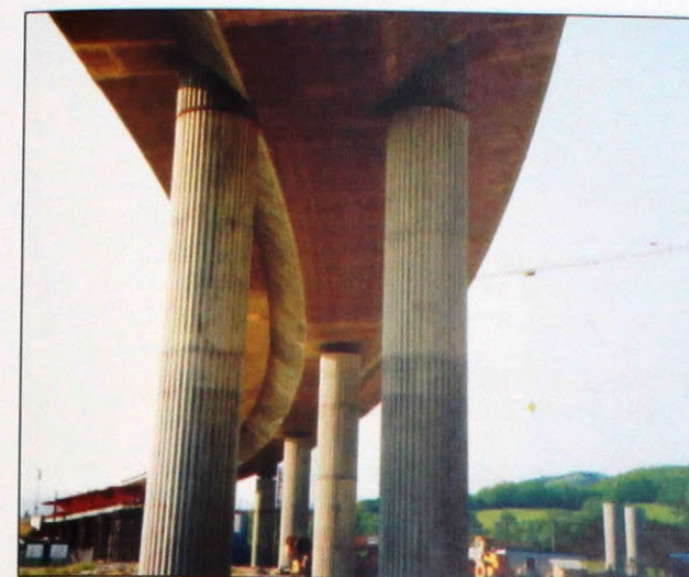
Obr. 2 Pohľad na rozostavané mosty Fig. 2 View on the bridges under construction
