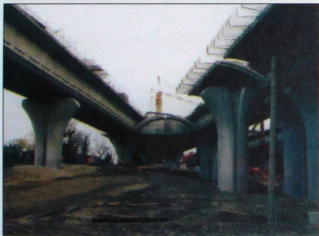
Obr. 7 Mosty v križovatke v štádiu výstavby Fig. 7 The flyover under construction
