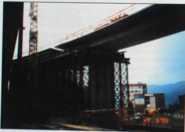
Obr. 2 Pohľad na podpernú skruž Fig. 2 Elevation - centering
