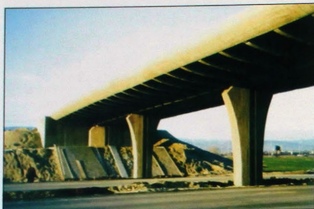
Obr. 3 Obj. 217 pred dokončením Fig. 3 Bridge 217 close to completion
