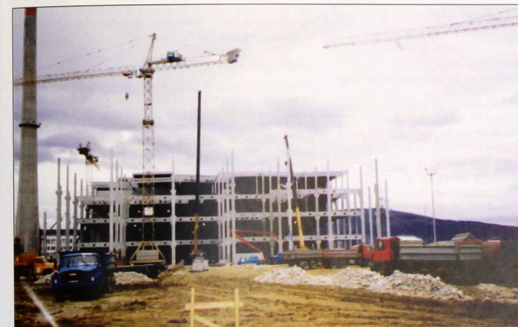
Obr. 4 Realizácia stavby - Nová Iakovňa - Devinská Nova Ves (Slovenská rep.) Fig. 4 Construction of the New spraying plant in Devinská Nova Ves (Slovak rep.)
