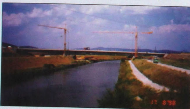
Obr. 3 Ľavý most pred dokončením Fig. 3 Left Bridge Prior to Completion of Works
