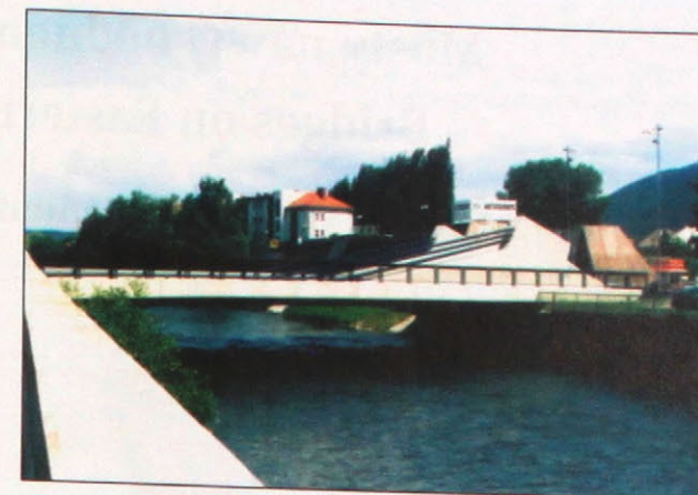
Obr.5 - Pohľad na most po dokončení Fig. 5 - View of the completed bridge
