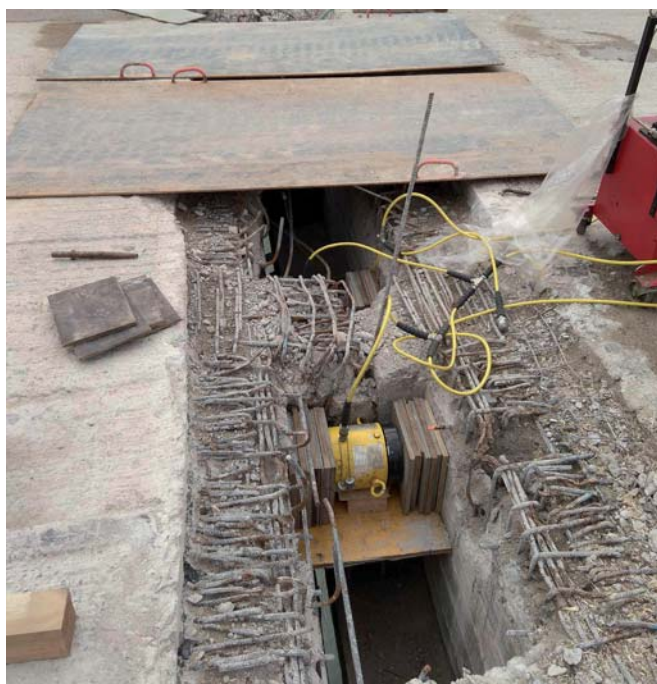
Obr. 7 Roztláčanie vahadiel nosnej konštrukcie Fig. 7 The process of pushing opposite cantilevers
