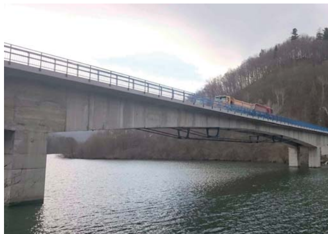
Obr. 12 Statická zaťažovacia skúška
