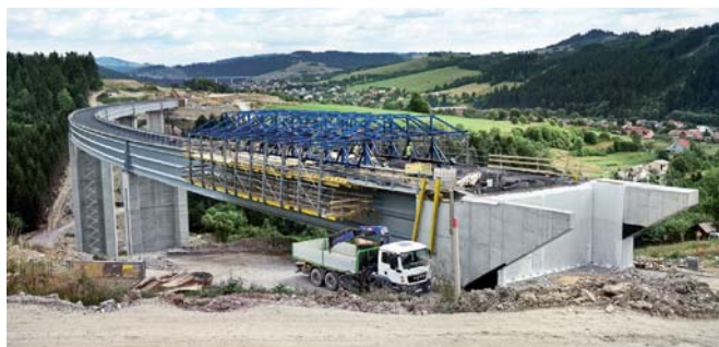
Obr. 4 Zhotovenie spriahnutej železobetónovej dosky so šírkou 13,41 m na mostoch Vášok a Čadečka sa realizovalo nasadením Doka-spriahnutého debniaceho vozíka v 7-dňovom takte. Fig. 4 The construction of a reinforced concrete slab with a width of 13.41 m of bridges Vášok a Čadečka was carried out by installing the Doka composite forming carriage in a 7-day cycle.
