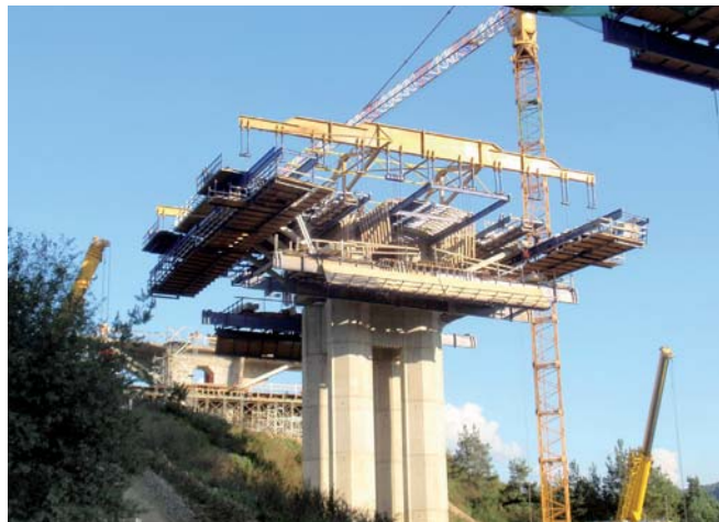
Montáž vozíkov letmej betonáže Installation of form travellers
