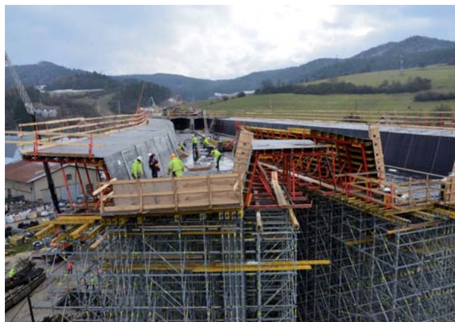
Pohľad na výstavbu DC2 (ľavý most s vetvou) View of the MU2 construction (left bridge with the ramp)
