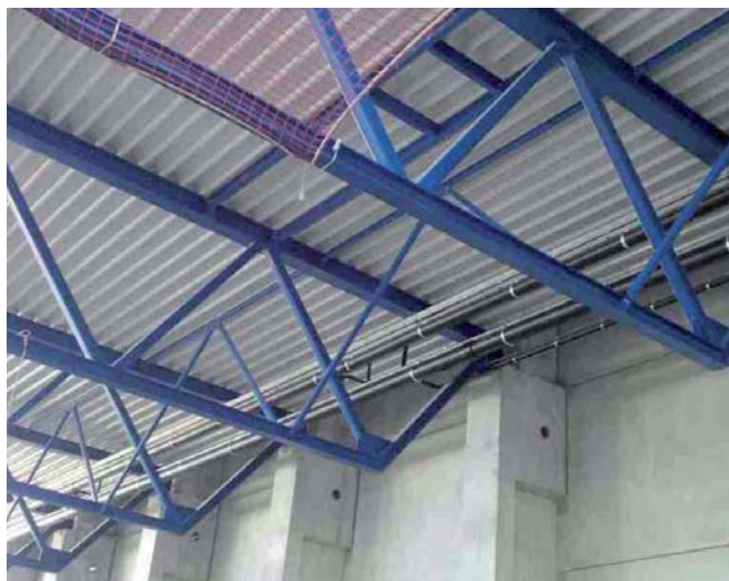
Obr. 10 Uloženie strešných oceľových väzníkov Fig. 10 Laying of steel roof girders
