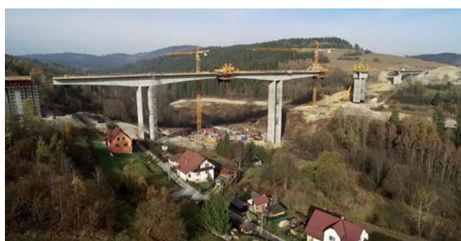
Dokončovanie vahadla P8, osádzanie betonážnych vozíkov na zárodok vahadla P10 Finishing of cantilever P8, installation of the concreting car on starting cantilever P10
