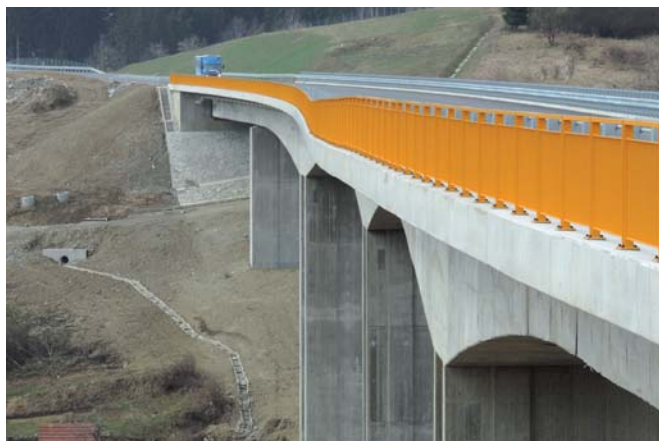
Pohľad na most tesne pred dokončením a uvedením do prevádzky View of the bridge shortly before the finishing
