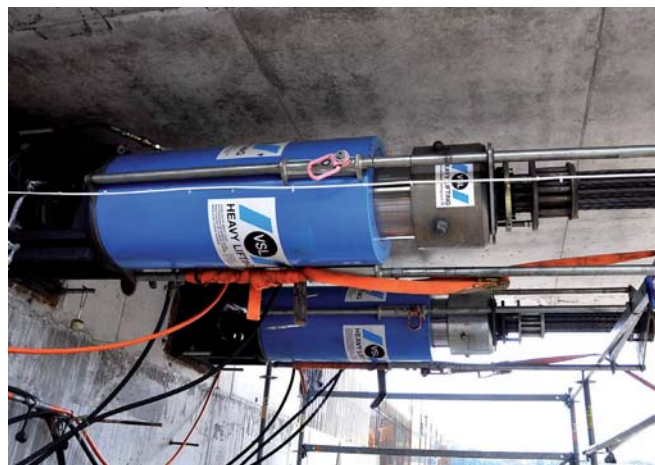
Ťažné pištoly SLU-330 firmy VSL SYSTÉMY (CZ) Launching jacks SLU-330, VSL SYSTÉMY (CZ)
