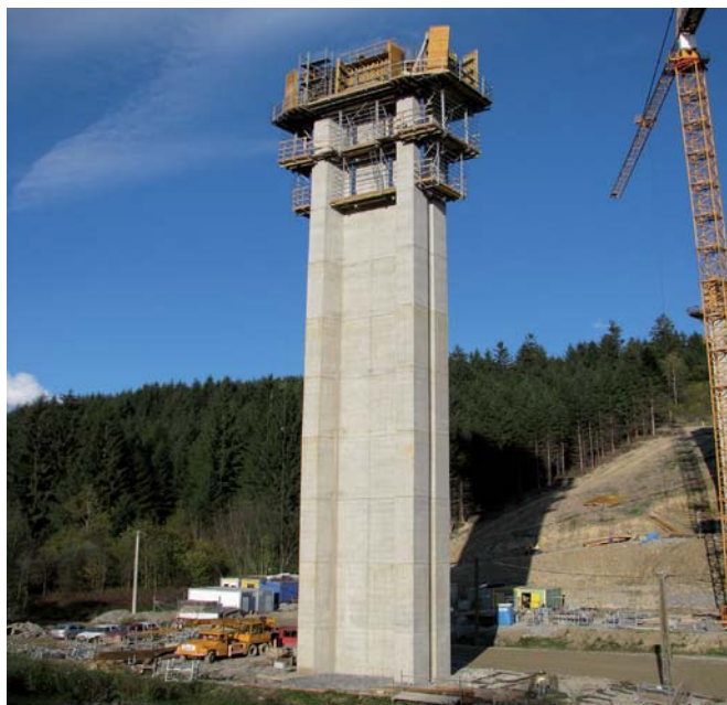
Obr. 3 Samošplhacie debnenie Xclimb 60 – šplhanie pomocou hydraulického agregátu a hydraulických komponentov Fig. 3 Automatic climbing formwork Xclimb 60 – climbing through the hydraulic aggregate and hydraulic components
