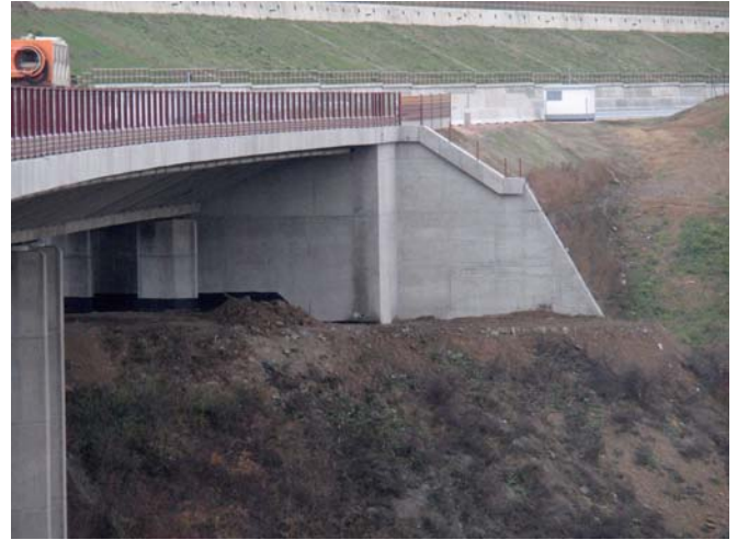
Pohľad na atypickú oporu č. 5 mosta SO 206 View of the atypical abutment no. 5 on bridge SO 206
