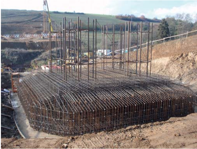
Výstuž základu so zárodkami stabilizačných veží Reinforcement of the foundation with pier heads for stabilization towers
