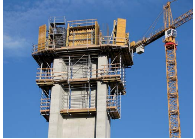
Obr. 2 Šplhacie debnenie MF 240 Fig. 2 Climbing formwork MF 240
