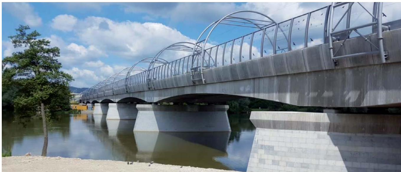
Pohľad na nový most View of the new bridge
