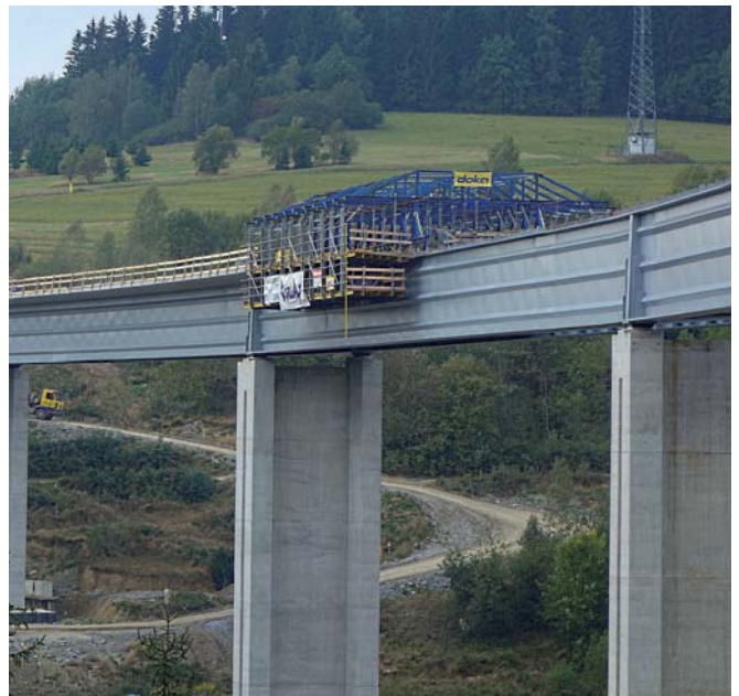
Obr. 6 Spriahnutá železobetónová doska so šírkou 13,41 m, výška oceľových I-profilov mosta je 4,05 m. Pomocou Doka-spriahnutého debniaceho vozíka s dĺžkou 25 m sa jeden takt zhotovuje 7 až 9 dní.
