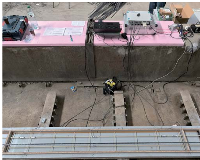
Obr. 4 Meranie pomerných pretvorení GFRP výstuže počas predpínania Fig. 4 Measurement of the relative strains of the GFRP reinforcement during pre-tensioning
