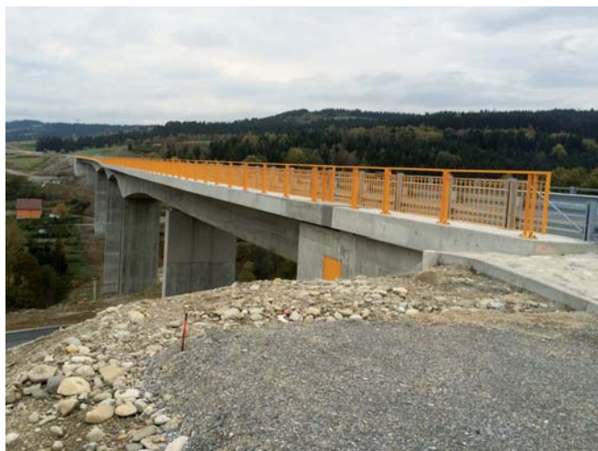
Zrealizované mostné príslušenstvo Executed equipment of the bridge
