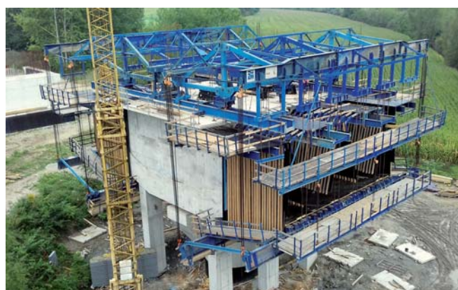
Obr. 3 Betonáž zárodku a prvých 3 m lamiel na betónovacích vozíkoch Fig. 3 The concreting of the pier segment and the first 3 segments constructed by the form travellers
