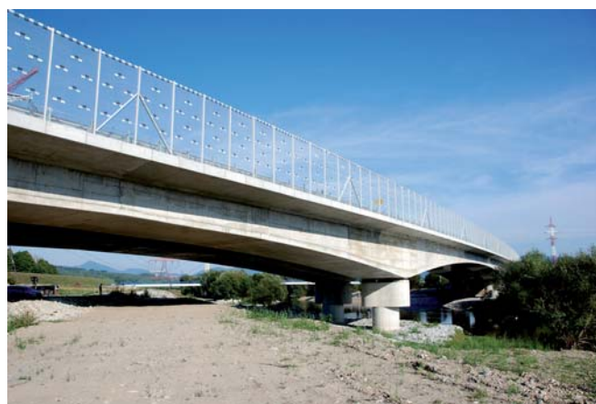
Most 205-00 pred uvedením do prevádzky Bridge 205-00 before putting in service
