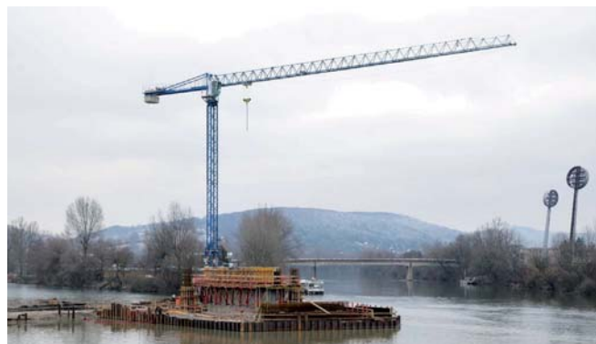
Pracovná plošina na realizáciu spodnej stavby Work platform for implementation of the substructure
