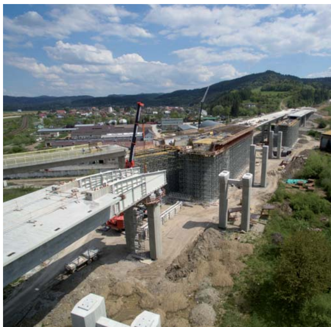
Pohľad na rozostavaný mostný objekt 201-00 View of the bridge, structure 201-00 under construction
