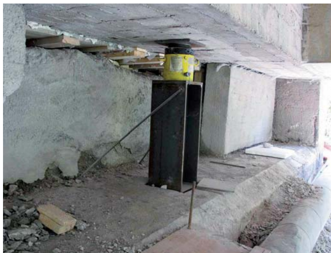
Obr. 10 Výmena kyvných stien za hrncové ložiská
