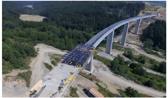
Obr. 5 Letecký pohľad na most Vršok počas realizácie Fig. 5 Aerial view of bridge Vršok during its realization
