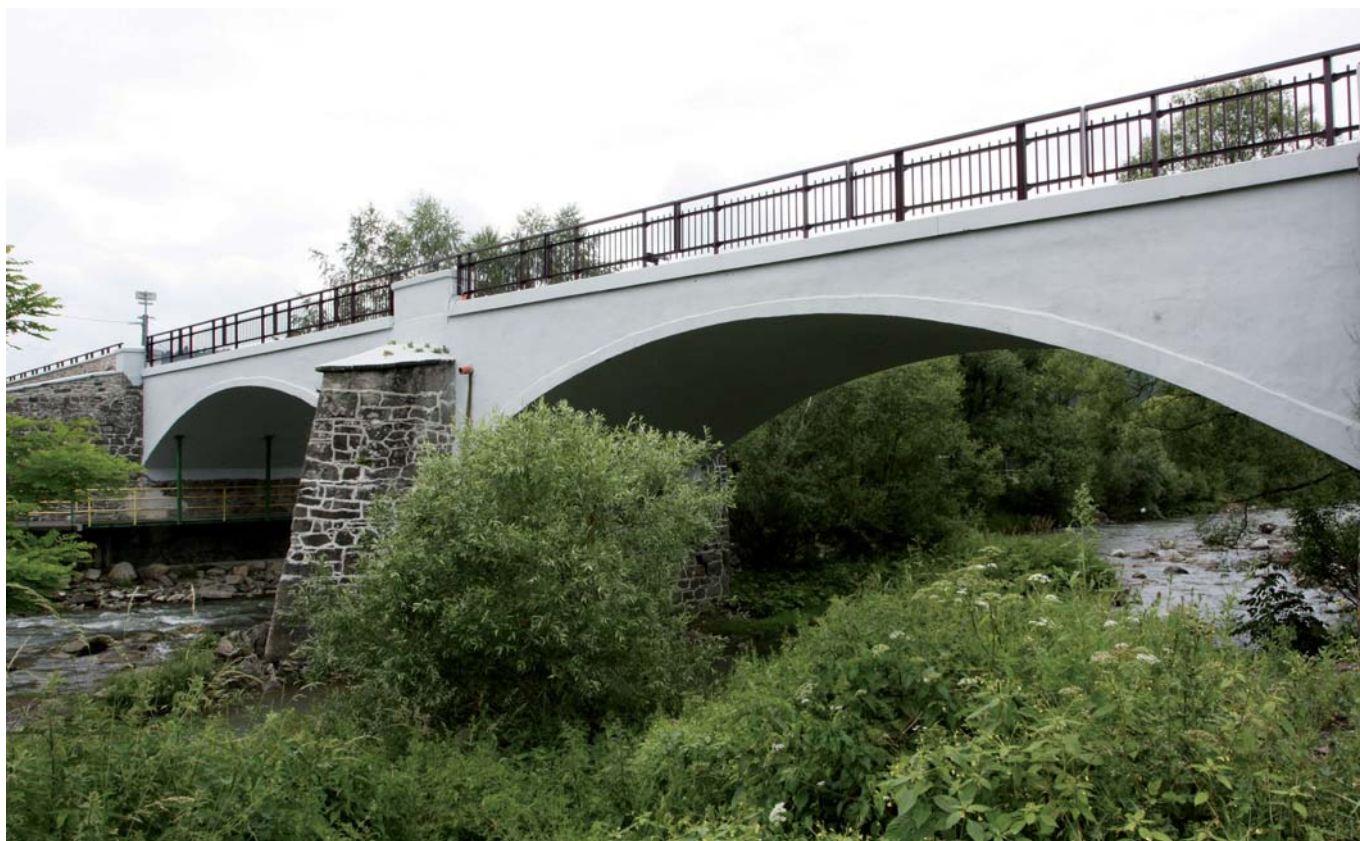
Obr. 4 Pohľad na most typu Monier v Krásne nad Kysucou po rekonštrukcii Fig. 4 Bridge in Krásno nad Kysucou after reconstruction
