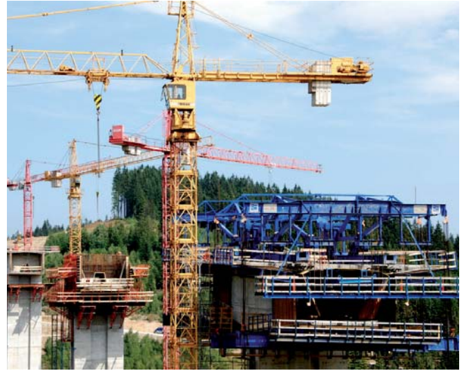
Realizácia nosnej konštrukcie Construction of the bearing structure
