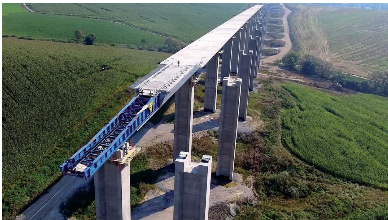
Výsuv nosnej konštrukcie ľavého mosta (8/2016) Left bridge superstructure launching (8/2016)
