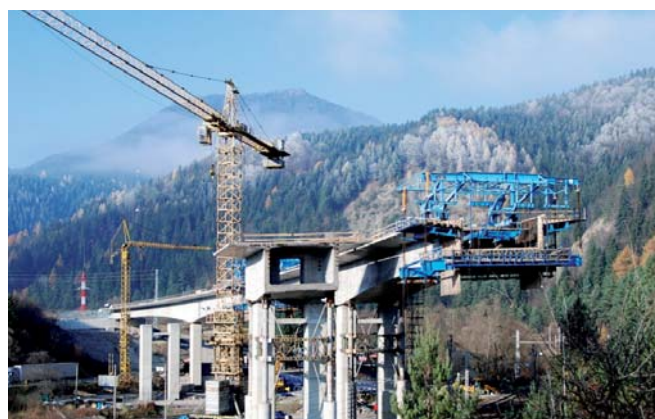
Obr. 5 Pohľad na zrealizovanú časť nosnej konštrukcie Fig. 5 View of the completed part of the superstructure
