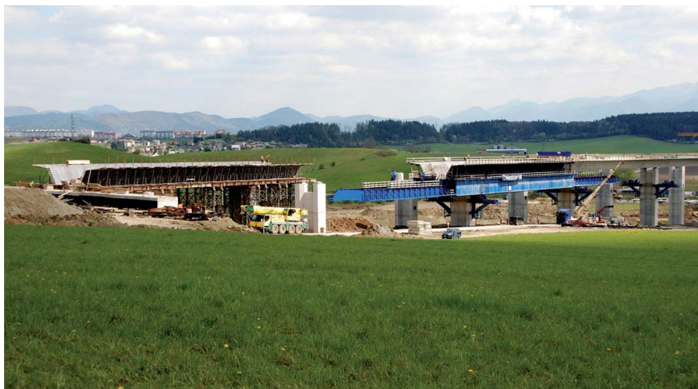
Obr. 4 Výstavba na pevnej skruži, 13. etapa
