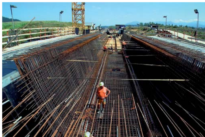
Pohľad do výroby pri výsuvu NK Fabrication plant during bridge launching
