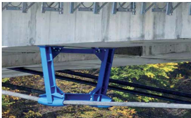
Obr. 9 Pohľad na oceľový deviátor a koncový priečnik
