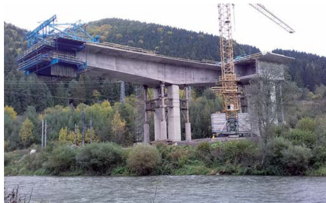
Obr. 4 Pohľad na rozostavané vahaďlo nad podperou č. 5 Fig. 4 View of the construction of the for cantilever above pier no. 5
