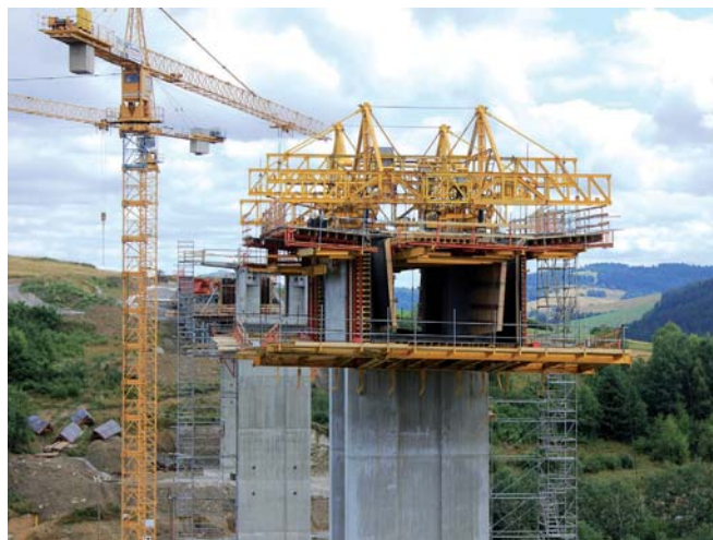
Osadený a pripravený pár betonážnych vozíkov na betonáž prvej lamely vahadla Pair of concreting cars which is installed and prepared for the concreting
