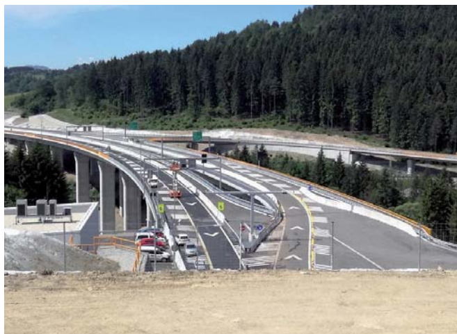
Obr. 1 Záber z prevádzky mosta, apríl 2018
