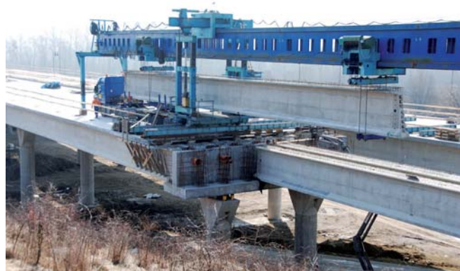
Obr. 3 Odoberanie nosníka zaväzácim zariadením z vozidla
