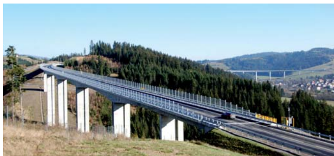
Pohľad na most Valy spustený do prevádzky View of the Valy bridge in operation
