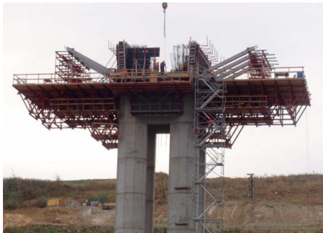
Výstavba zárodku na plošine ULMA Construction of the pier head on the ULMA platform
