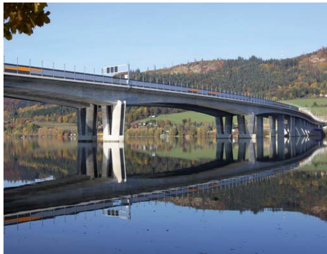
Obr. 9 Most v priestore VN Hričov po dokončení
