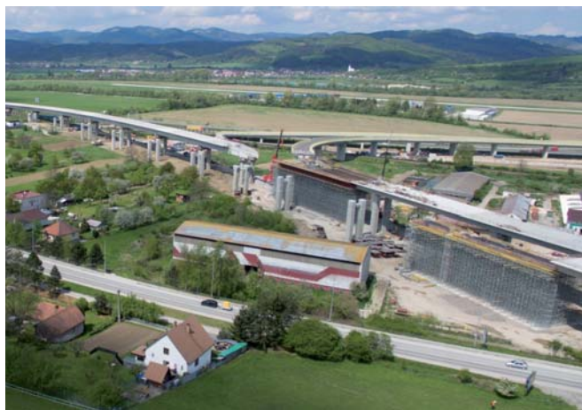
Pohľad na výstavbu mosta View of the bridge construction
