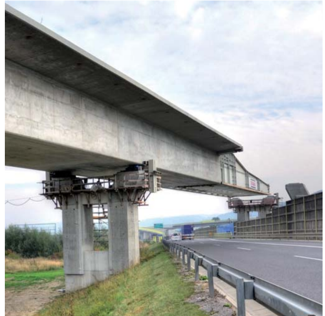
Obj. 201-00, DC1, výsuvný nos Structure 201-00, MU1, launching nose
