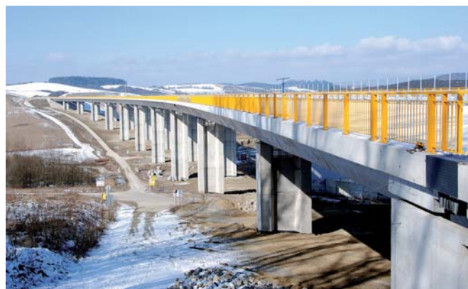
Obr. 1 Pohľad na nosnú konštrukciu pravého mosta SO 205-00 Fig. 1 View of the bearing structure of the right bridge SO 205-00
