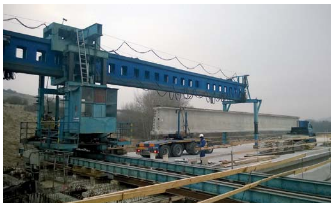
Doprava a osadenie predpätých nosníkov Transport and placement of precast prestressed beams
