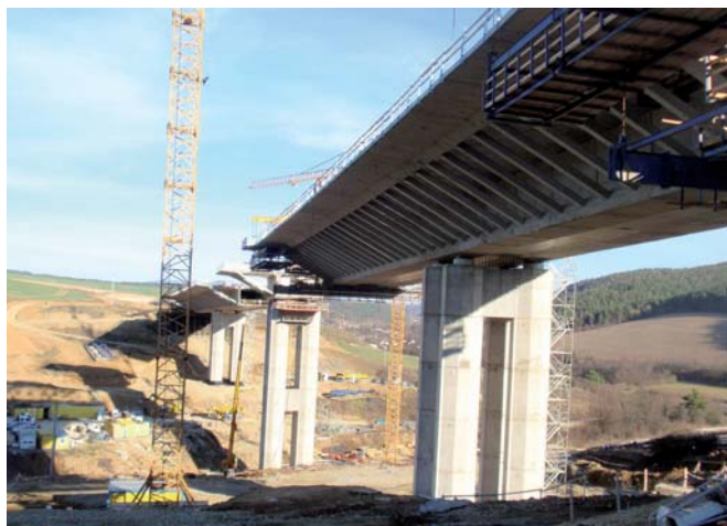
Pohľad na rozostavané vahadlá mosta SO 204 View of the unfinished cantilevers on SO 204
