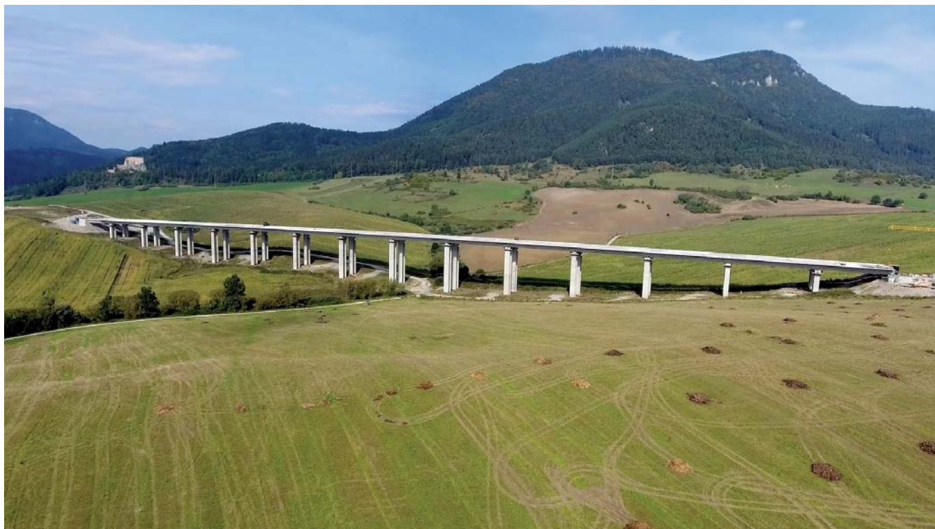
Pohľad na obidve vysunuté nosné konštrukcie Both fully launched bridge structures
