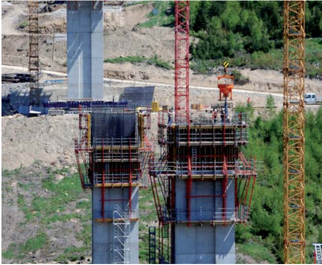
Výstavba pilierov Construction of the piers
