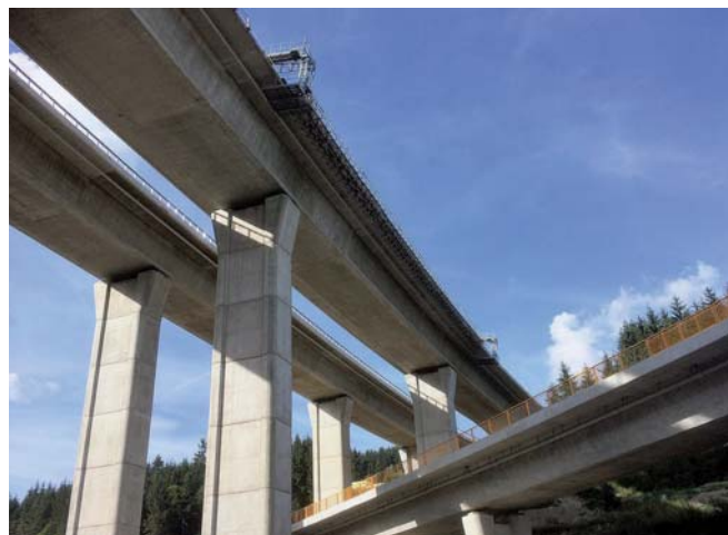
Obr. 2 Kríženie vysúvaného mosta SO 237-10 s mostom SO 237-20 na vetve A
