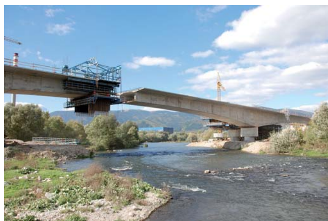
Výstavba obj. 205-00, pohľad na piliere 3, 4 a na krajné pole Construction of Structure 205-00, view of piers 3 and 4 and the end span
