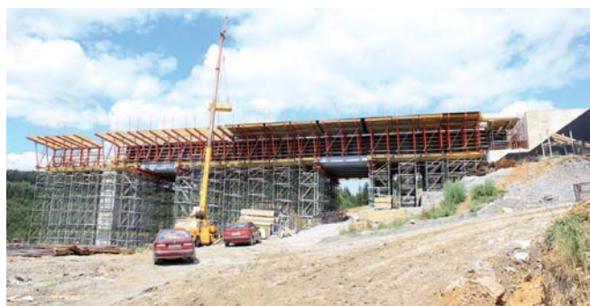
Budovanie nosnej konštrukcie na pevnej skruži Execution of the structure on scaffolding
