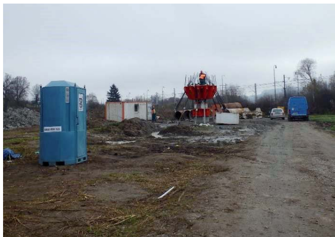
Zaťažovacia skúška pilóty – vľavo zaťažovací most, vpravo vybavenie armokoša tenzometrami Pile load test – load bridge on the left side, strain gauges in rebar cage on the right side
