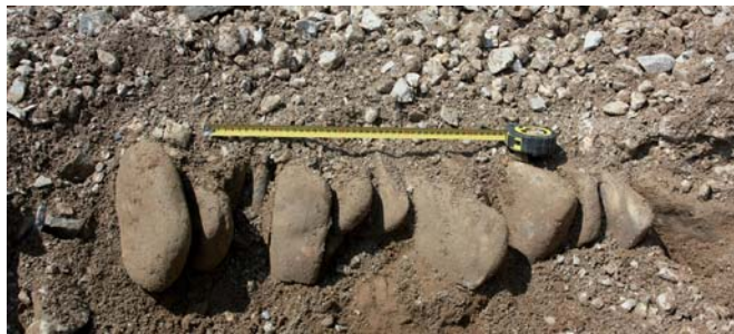
Obr. 2 Odkrytá pôvodná vrstva vozovky z 19. storočia, ktorá sa nachádzala pod vrstvami asfaltu na moste v Krásne nad Kysucou. Fig. 2 Original road pavement from 19-th century found under asphalt layers at the bridge in Krásno nad Kysucou.
