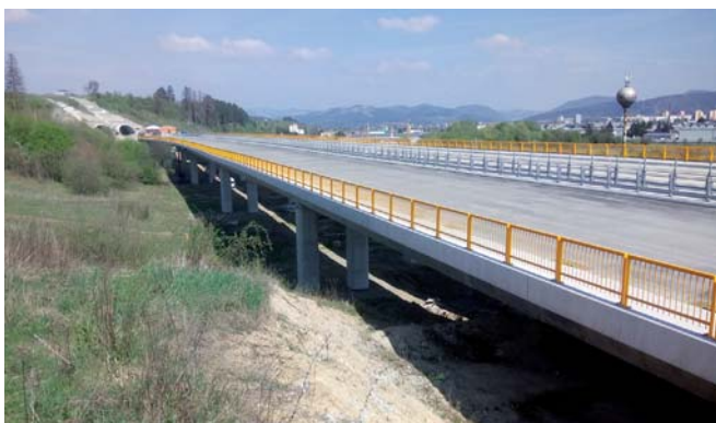
Objekt 209-00, pohľad pred dokončením Structure 209-00, view before finishing
