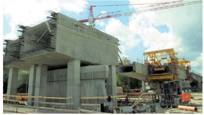
Realizácia nosnej konštrukcie Implementation of the superstructure
