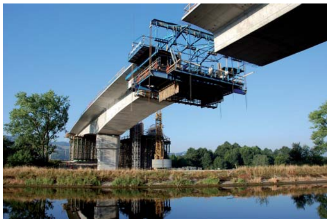
SO 225-00 DC2, výstavba nosnej konštrukcie Structure 225-00 MU2, superstructure construction
