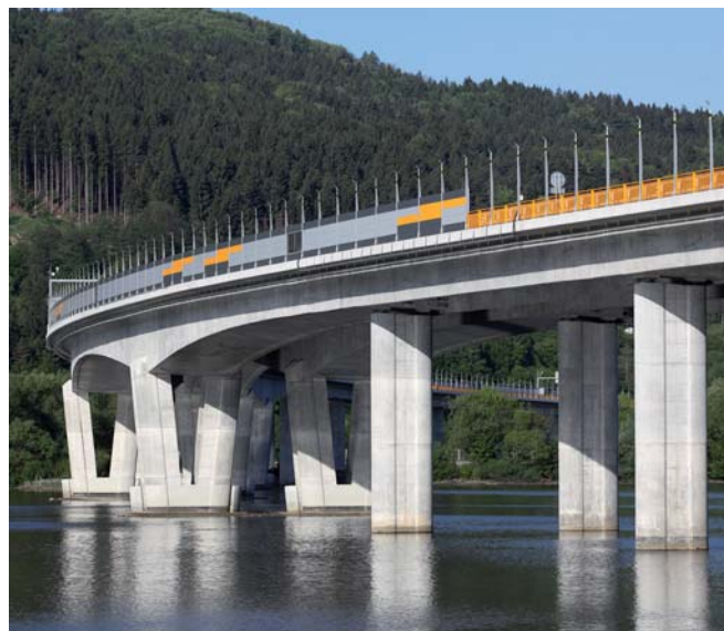
Obr. 8 Výškový nábeh komorovej časti smerom k pilierom v tvare V vo VN Hričov Fig. 8 Cross-section height variation close to V-shaped piers at reservoir section
