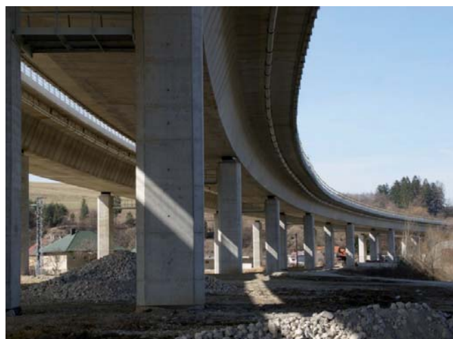
Objekt 209-00, pohľad na časť mostného objektu Structure 209-00, view of bridge part
