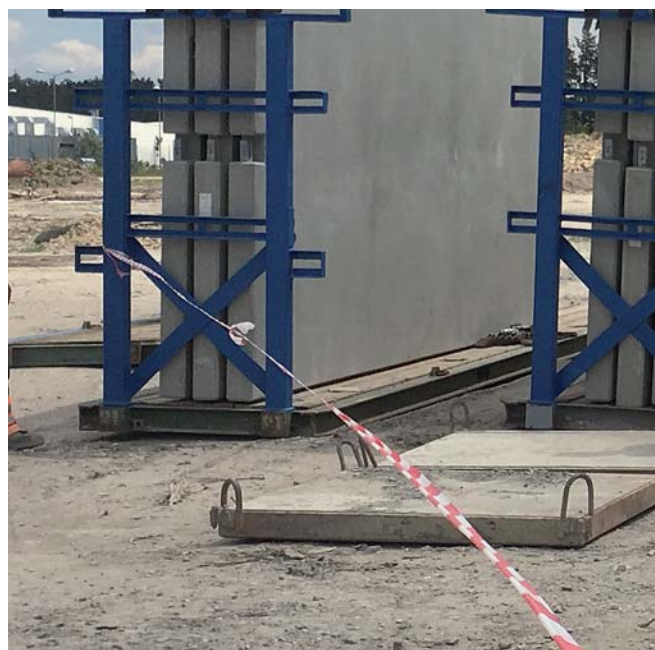
Obr. 9 Stenové panely pred montážou Fig. 9 Wall panels before installation
