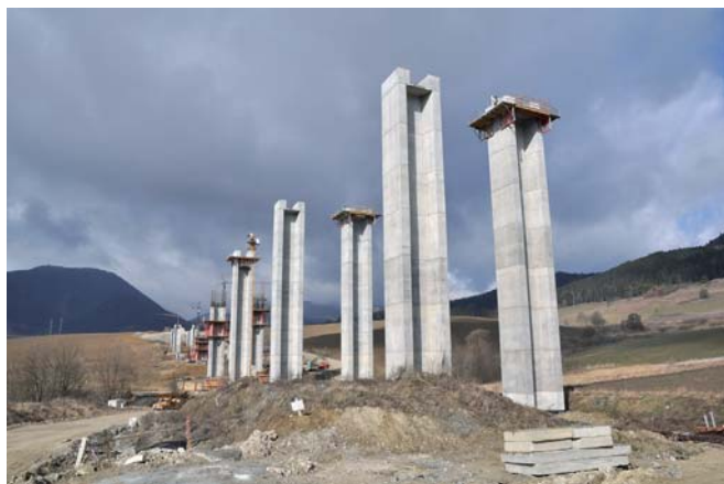
Výstavba pilierov Piers construction
