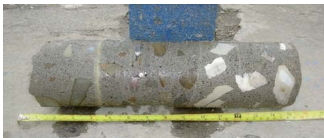
Obr. 3 Jadrový vývrt z klenby mosta v Krásne nad Kysucou s viditeľným rozhraním medzi betónom klenby a nadbetónávkou. Fig. 3 Drilled core sample from the bridge in Krásno nad Kysucou with visible interface between the concrete of the arch and arch overfill.
