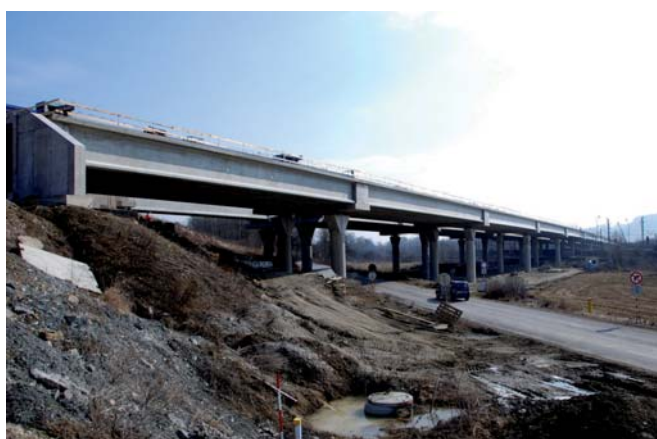
Pohľad na dokončenú výstavbu nosnej konštrukcie View of the finished construction of bridge superstructure
