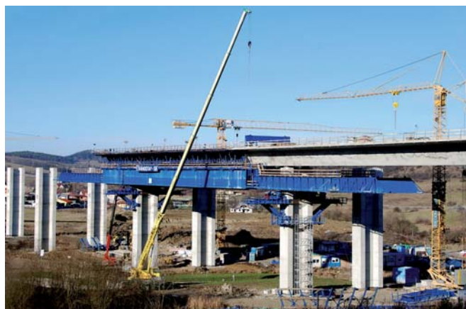
Obr. 3 Výstavba NK na výsuvnej skruži Fig. 3 Construction of the bearing structure by the movable scaffolding method
