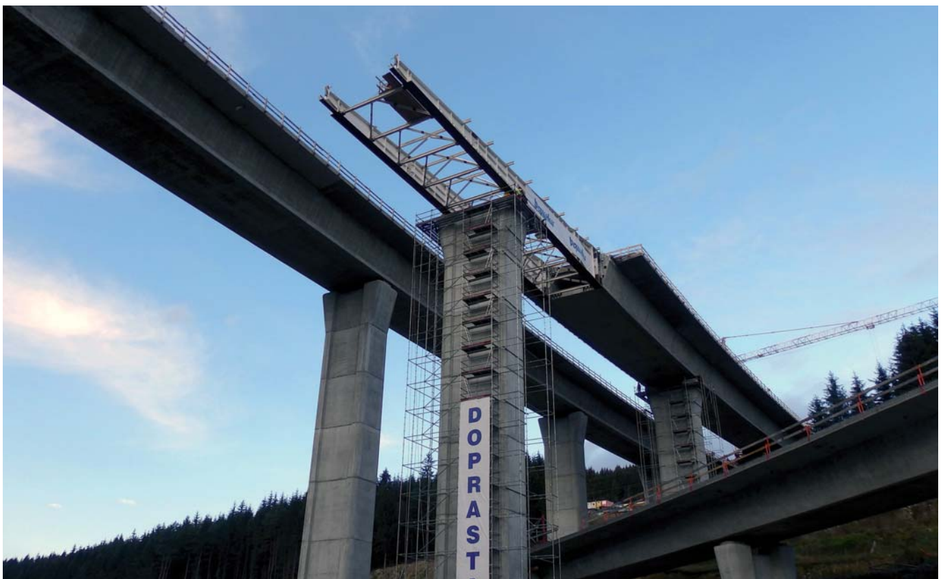
Obr. 5 Výsuv ľavého mosta pri navádzaní na pilier č. 7 Fig. 5 Launching of the left bridge onto pillar 7
