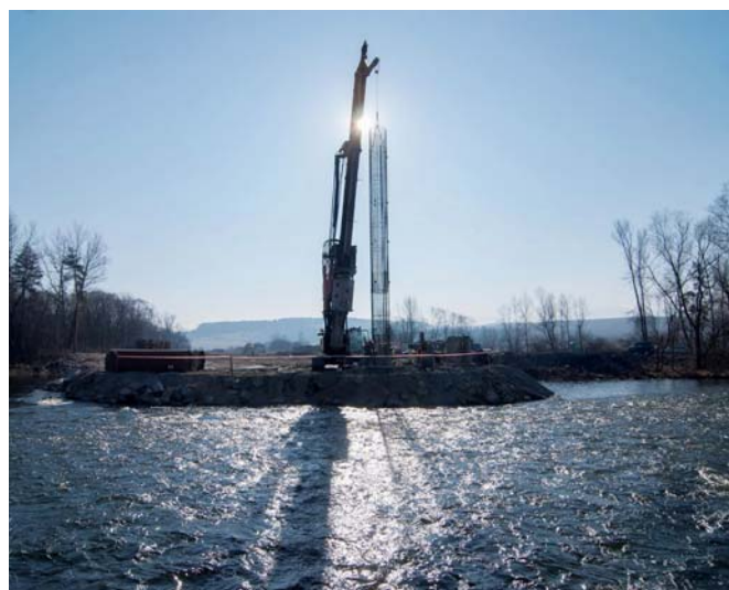
Práce na zakladaní mosta – vľavo realizácia pilôt v Váhu, vpravo realizácia mikropilôt v zemnom telese Foundation works – piling in the river on the left side, micro piling between ŽSR tracks on the right side
