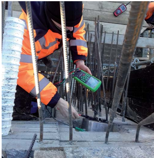
Obr. 7 Meranie elektrického odporu kábla pred injektážou Fig. 7 Measuring of tendon's electric resistance before grouting
