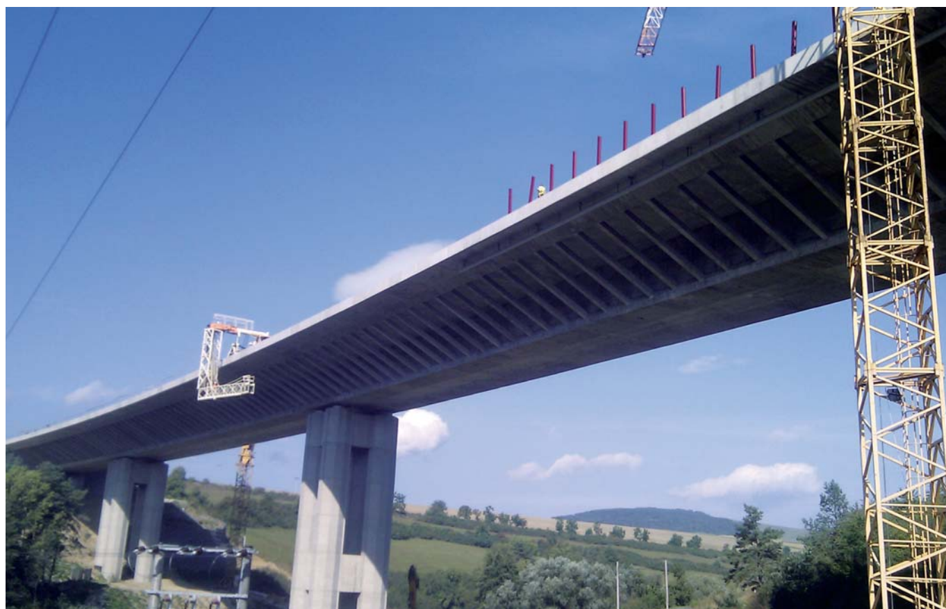
Pohľad na most SO 206 pred dokončením View of the SO 206 bridge before completion
