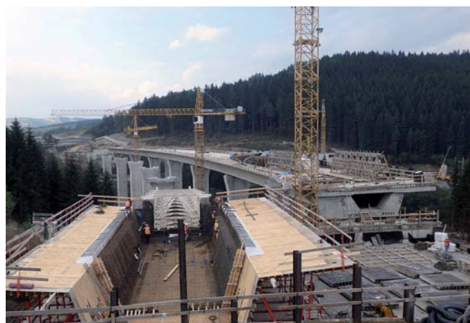
Obr. 4 Priečny presun výrobného po ukončení NK ľavého mosta
