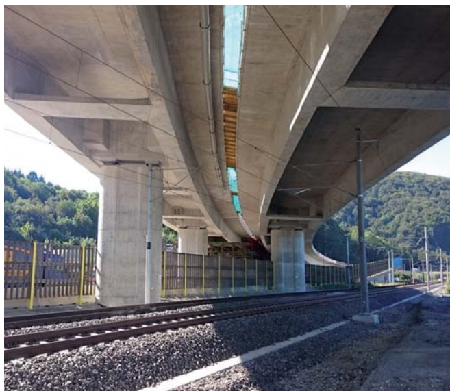
Obr. 5 Pole TC1 nad traťou ŽSR a vzpery v rozšírení trámov
