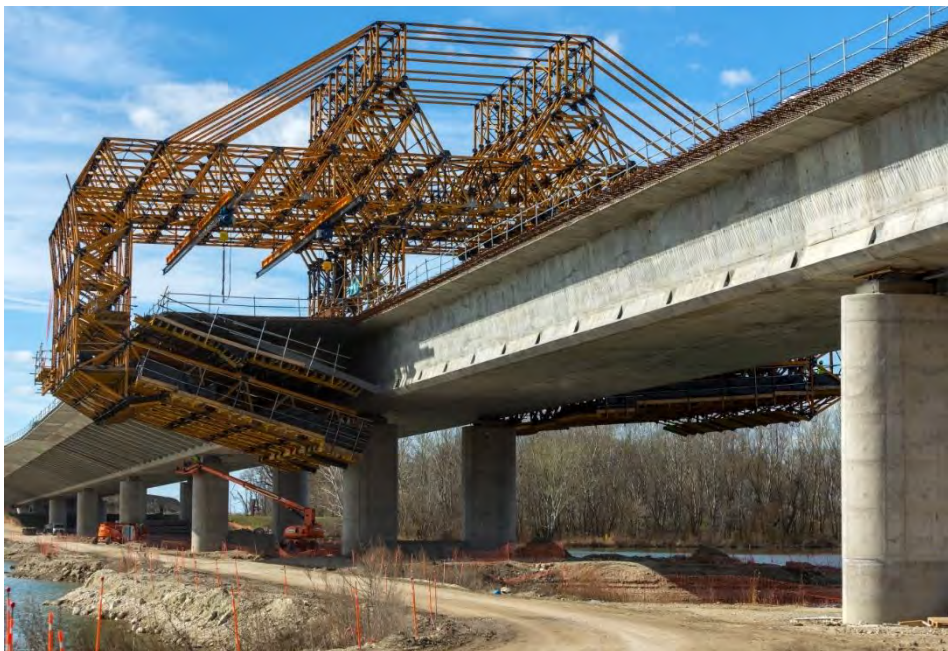
Obr. 4 Výstavba konzol nosnej konštrukcie pomocou posuvnej skruže
