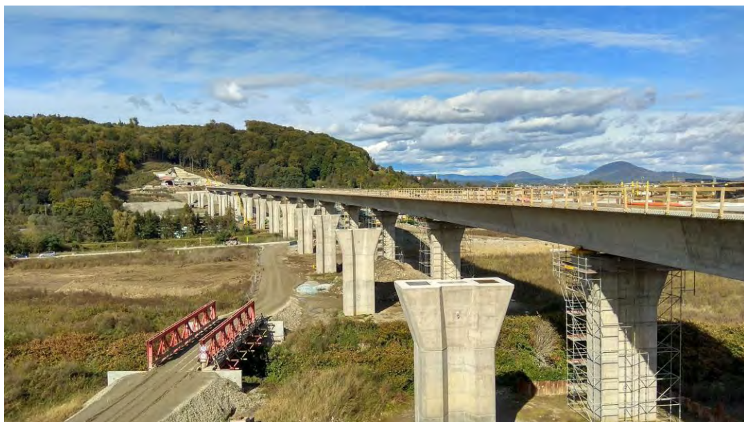
Obrázok č.2 – LM pred dokončením výsunu
