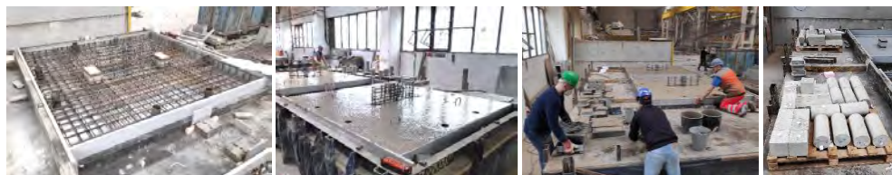
Obr.2.2- Výroba vzoriek: pohľad do debnenia, vzorka po zabetónovaní, zhotovenie materiálových vzoriek
