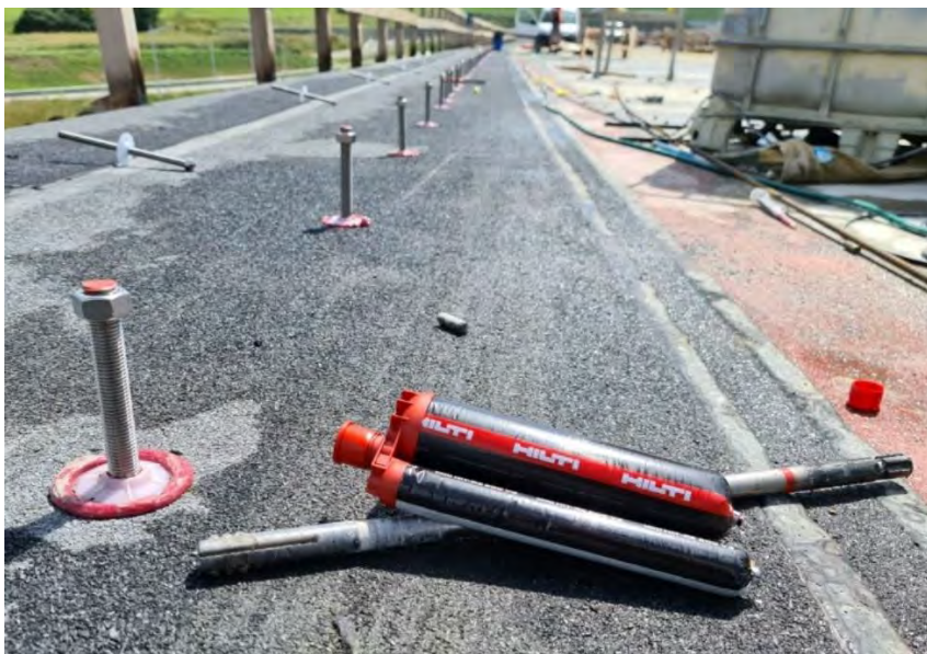
Obr. 2 Nové ukotvenie rímky na moste 201-00 D1 Prešov, západ – Prešov, juh
