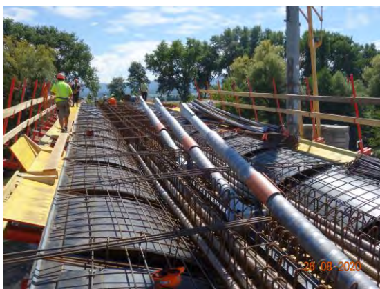
Obr. 2 Pohľad na oceľové prvky do ktorých sa následne kotvia tyčové závesy
