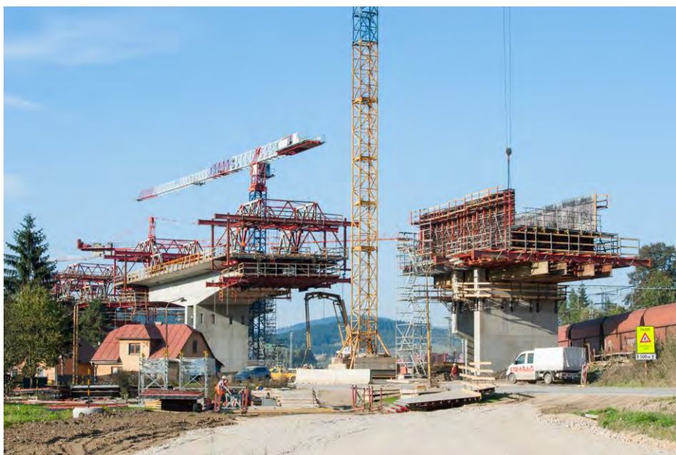
Obr. 6 Pohľad na výstavbu komorovej konštrukcie
