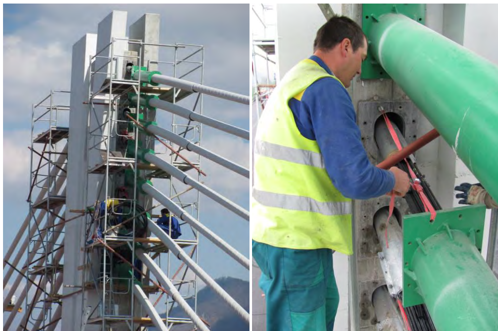
Obr. 2: Ukážka z realizácie konvenčných sediel z projektu: estakáda Považská Bystrica budovaná v rámci úseku D1Sverepec – Vrtižer z roku 2010
