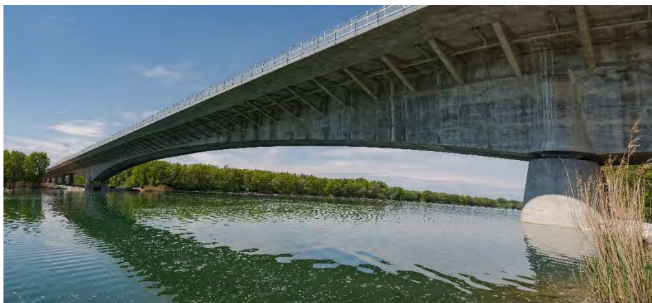
Obr. 4. Pohľad na dokončený mostný objekt
