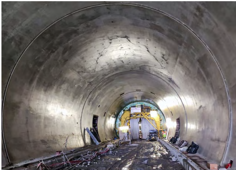
Obr. 6 Pohľad na vybetónovaný blok sekundárneho ostenia
