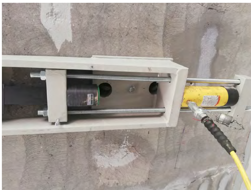
Obr. 4. Predpínanie lamely na strane aktívnej kotvy
