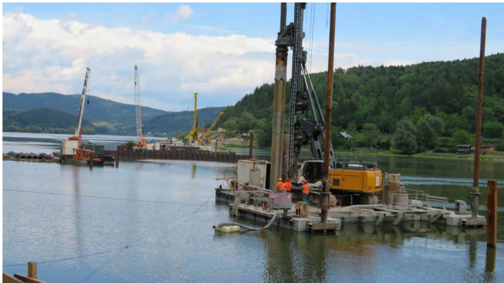
Obr. 2: Vrtanie pilót z plávajúceho pontóna
