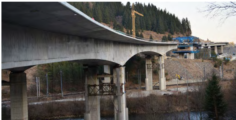
Obr.6 Pohľad na rozostavanú časť nosnej konštrukcie
