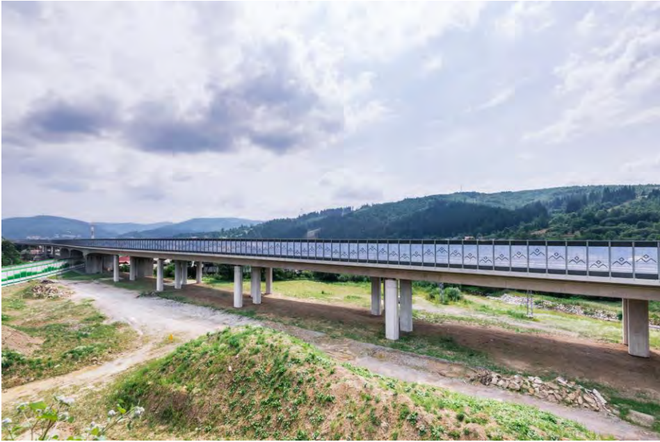
Obr. 7 Pohľad na dokončený most
