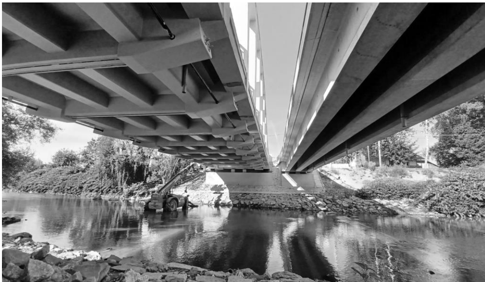
Obr. 5 Zosilnenie nosnej konštrukcie
