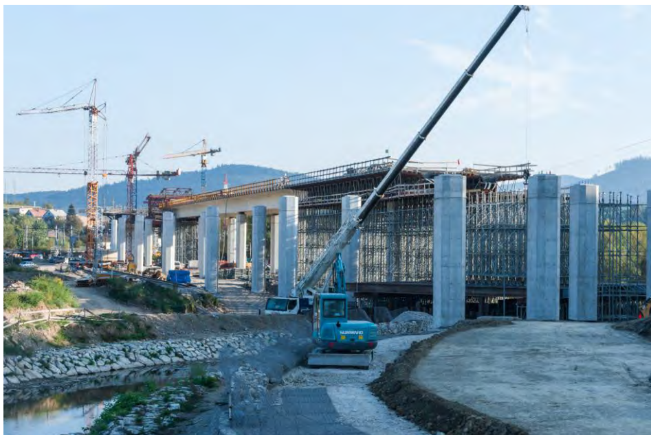
Obr. 5 Pohľad na výstavbu dvojtrámovej konštrukcie
