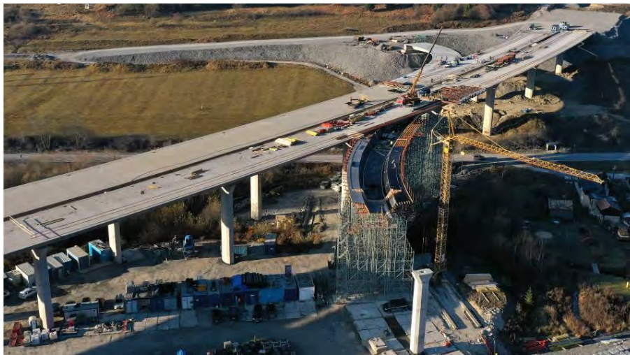
Obr. 8 – Postupná betonáž polí ramp
