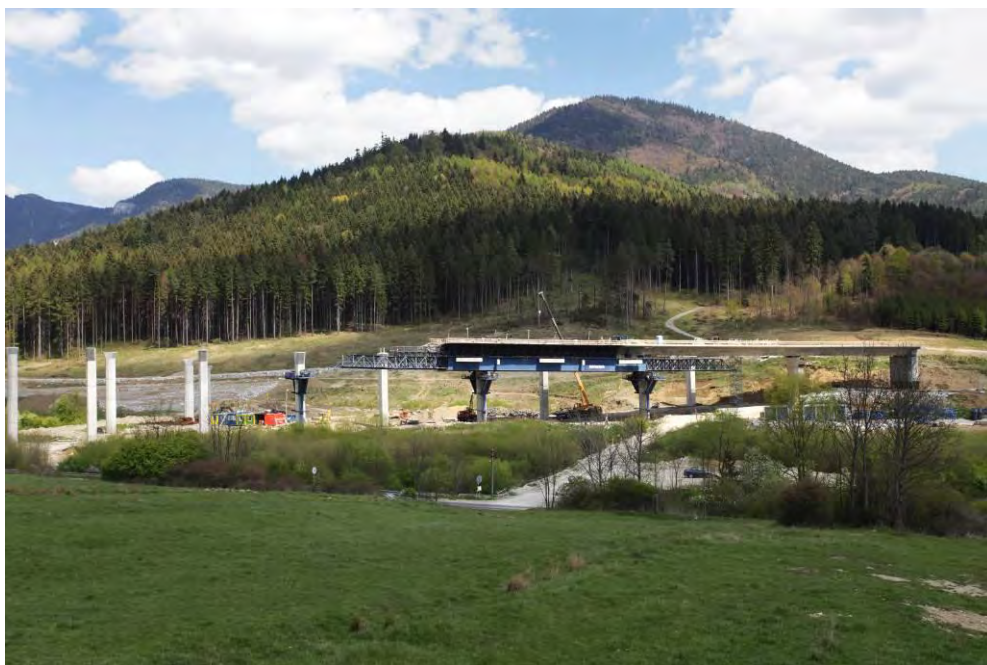
Obr. 7 – Postupná betonáž polí hlavního mostu
