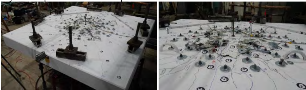
Obr. 4.2 Doska FS-03 po porušení
