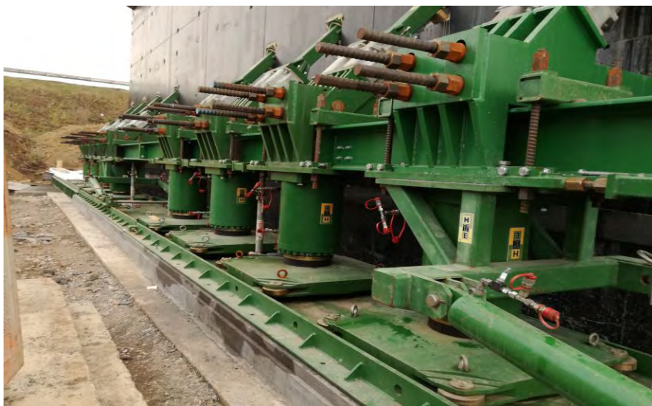
Obrázok č.4 – detail zdvihových jednotiek
