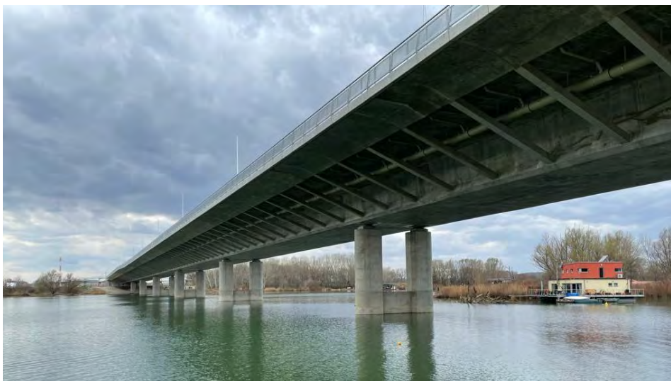
Obr. 5 Pohľad na most nad Jaroveckým ramenom
