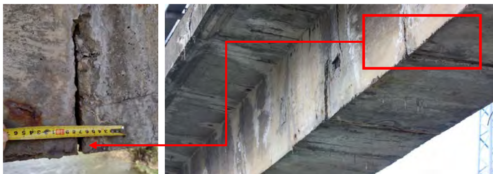
Obr. 2: Roztvorenie škár medzi segmentmi v strede poľa.
