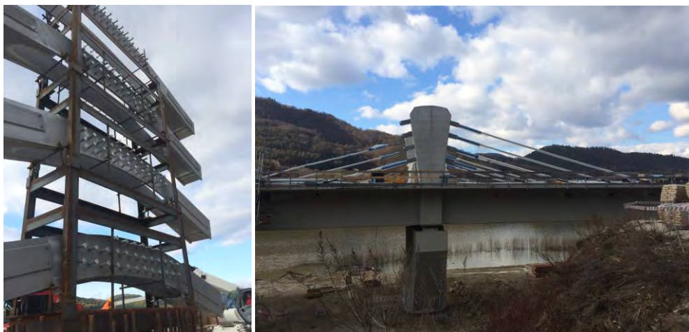
Obr. 5: Osadenie prípravkov DYNA® Link Anchor Box (vľavo) a samotná montáž extradosových káblov (vpravo)
