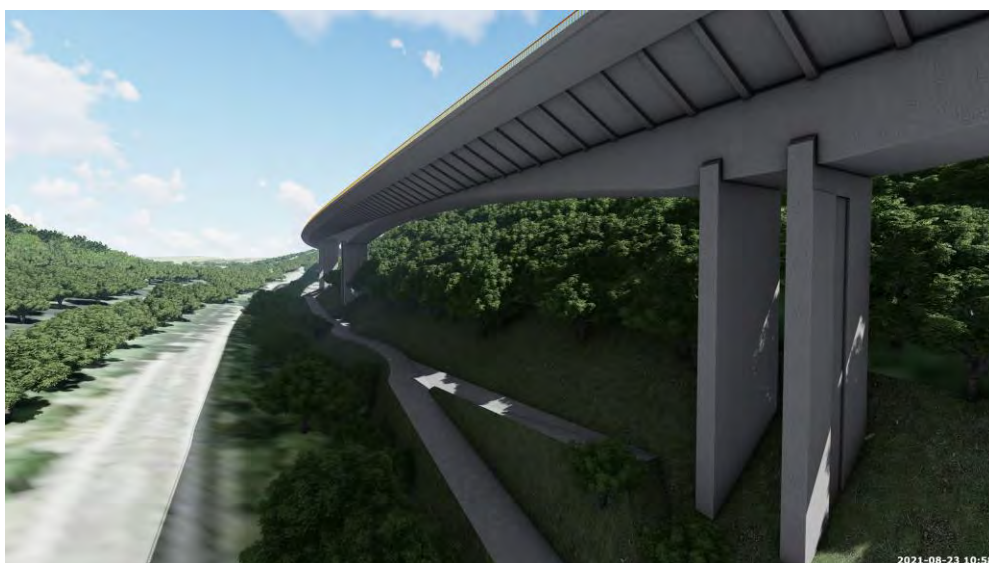
Obr. 3 – 209-01 Vizualizácie dilatačného celku stavaného letnou betonážou
