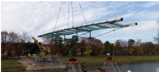
Obr. 7 – Montáž mostovky
