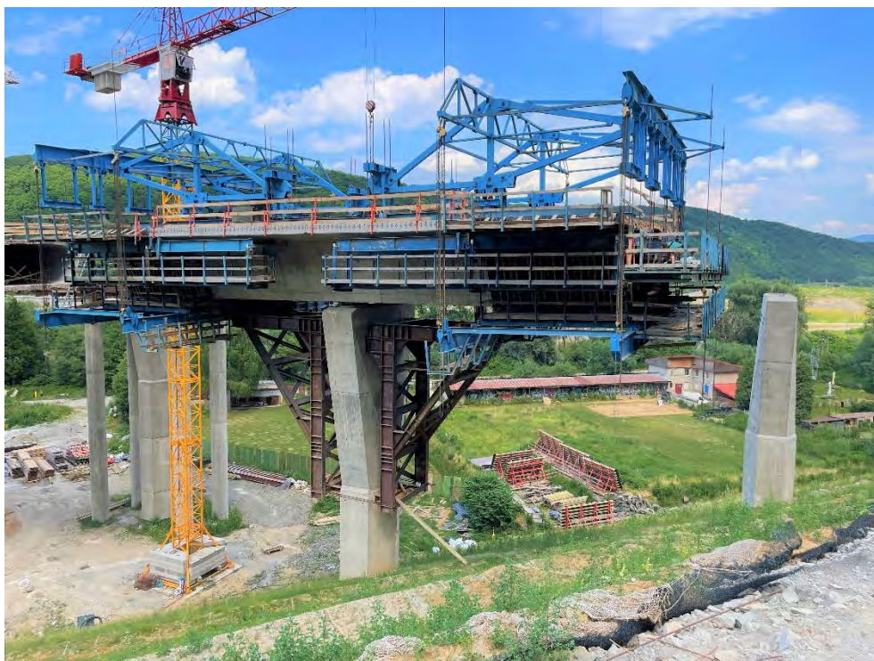
Obr. č.3 Realizácia vahadla pomocou vozíkov LB
