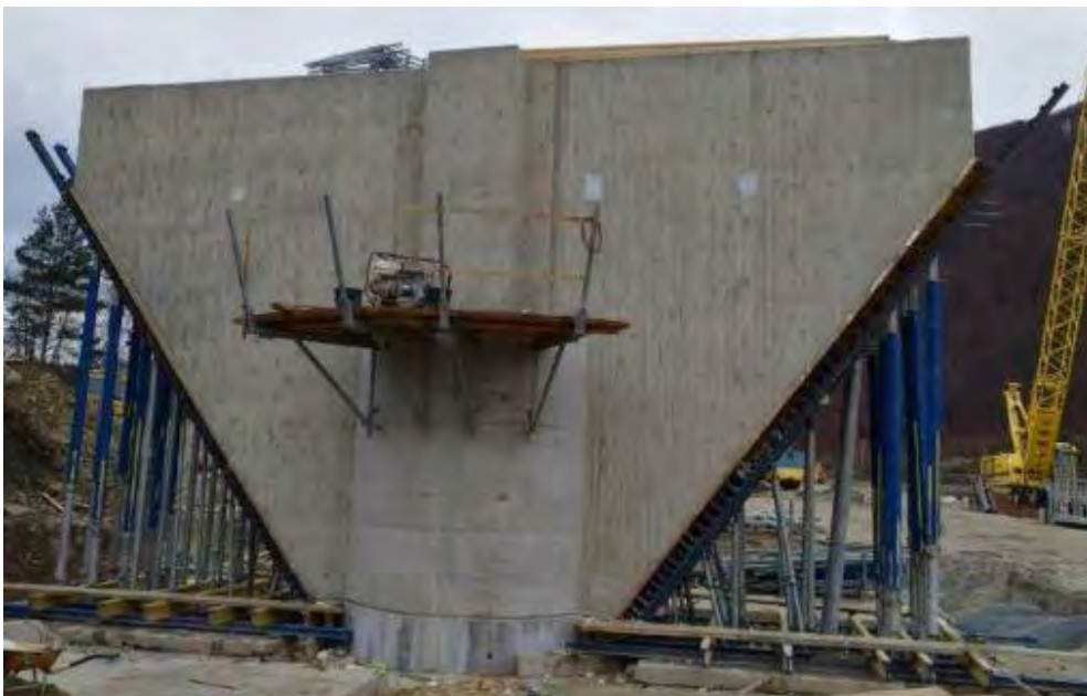
Obr. č. 3 Pohľad na zabetónovanú hlavicu piliera
