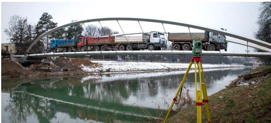
Obr. 10 – Statická zatěžovací zkouška
