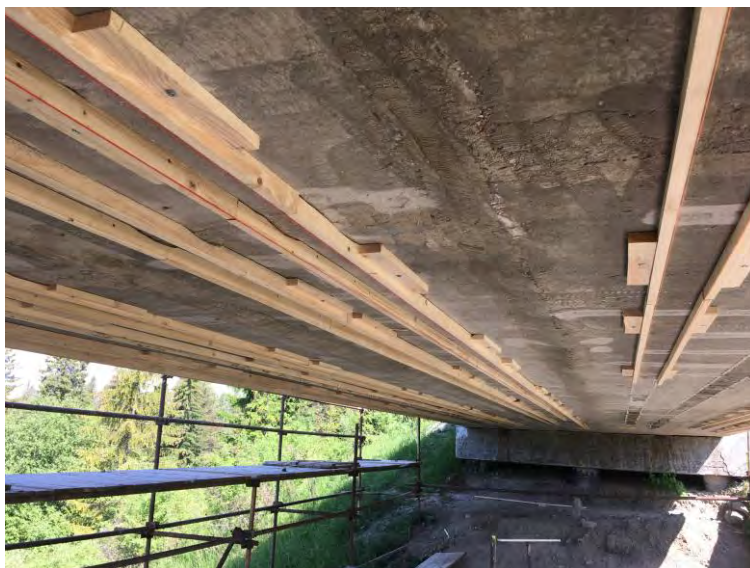
Obr. 1. Príprava priestoru na sanáciu podkladu pred zosilňovaním
