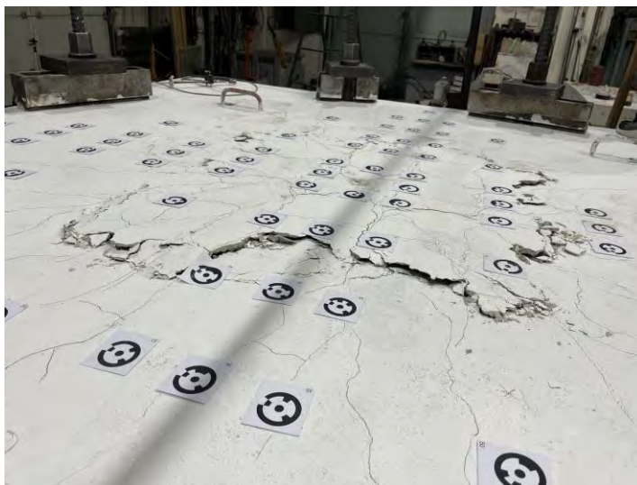
Obr. 4.3 Zlyhanie jednej z dosiek s GFRP výstužou
