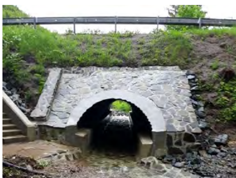
Obr. 4 – a) priečný rez mosta po rekonštrukcii , b) pohľad na poruchy mosta, c) ilustračný obrázok mosta po rekonštrukcii pomocou technológie „relining“
