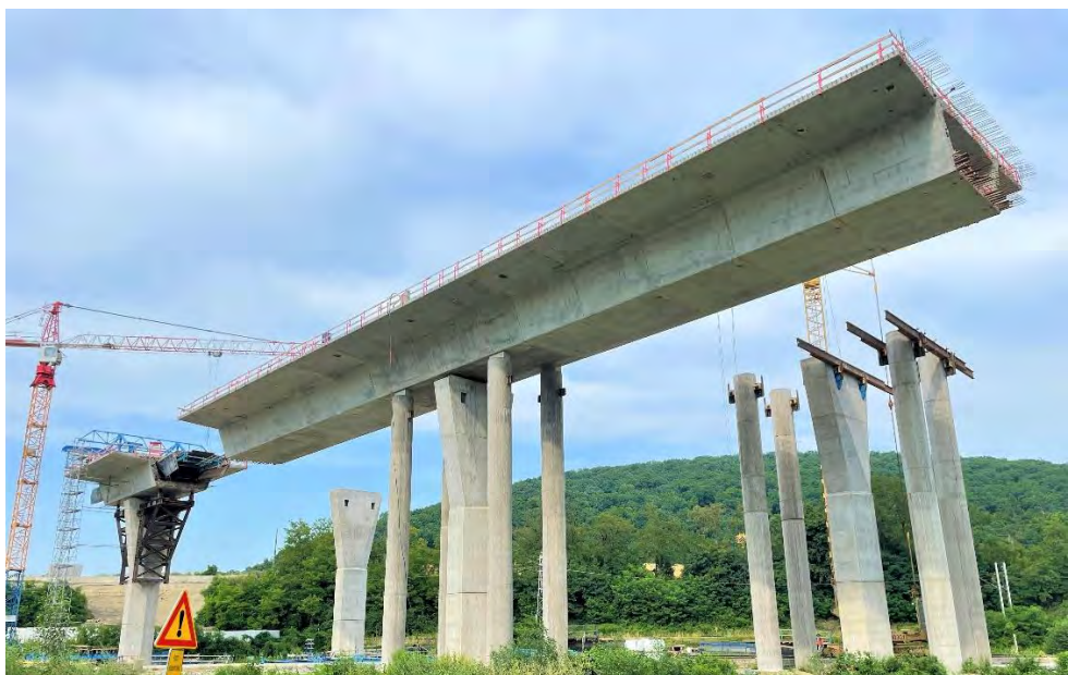
Obr. č.4 Pohľad na zrealizované vahadlo
