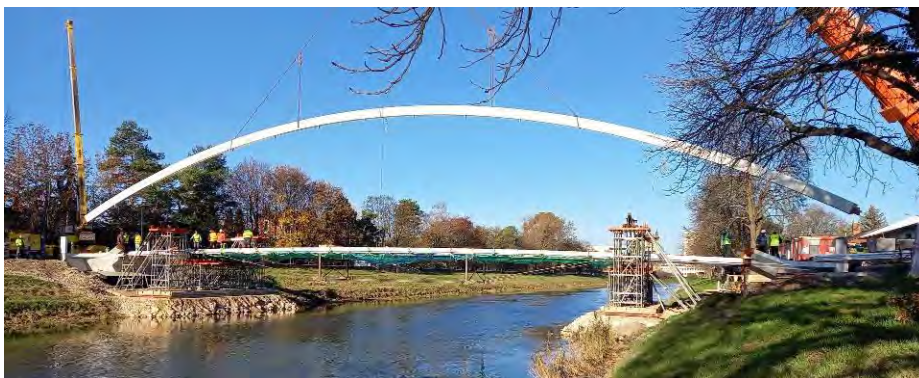
Obr. 9 – Montáž oblouku
