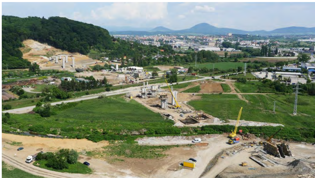
Obrázok č.1 – Spodná stavba v realizácii
