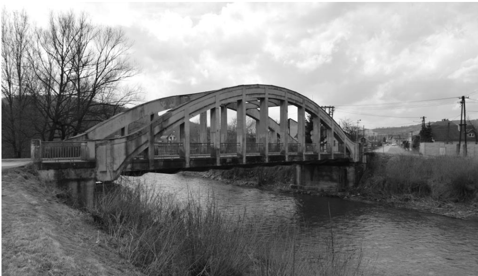
Obr. 1 Pohľad na most pred rekonštrukciou
