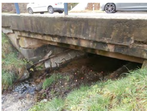
Obr. 4 – a) priečný rez mosta po rekonštrukcii , b) pohľad na poruchy mosta, c) ilustračný obrázok mosta po rekonštrukcii pomocou technológie „relining“
