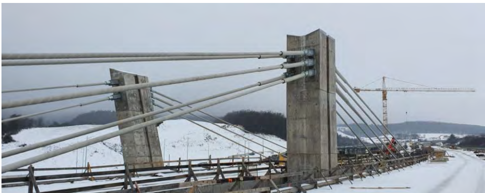
Obr. 1: Pohľad na realizáciu extradosových káblov na projekte D1 Prešov, západ – Prešov, juh
