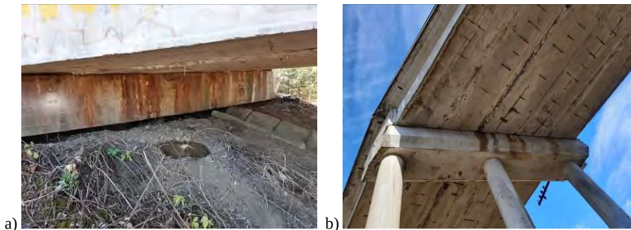
Obr. 2 Poruchy na mostoch – priesaky medzi nosníkmi a priesaky (netesnosť) cez dilatčné škáry na oporách (a), priesaky cez dilatčné škáry na úložných prahoch piliera a korózia strmeňov nosníkov (b)
