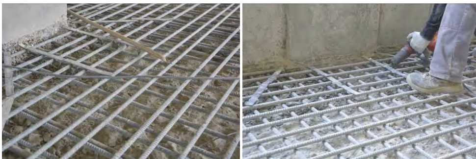
Obr.4 Odstraňovanie poškodenej vrstvy ŽB dosky
