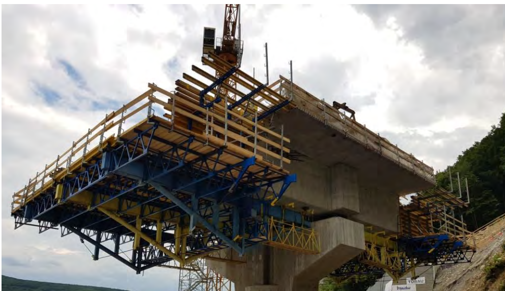
Obr. č. 5 Montáž vozíkov letmej betonáže
