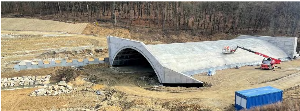
Obrázok 4. Realizácia mostného objektu SO 233 – pohľad na klenbu a portálové časti, realizácia násypu s postupným budovaním súvisiaceho oporného múru a prekládky potoka Dzikov (SO 322)
