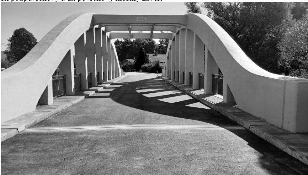
Obr. 2 Pohľad na most po rekonštrukcii
