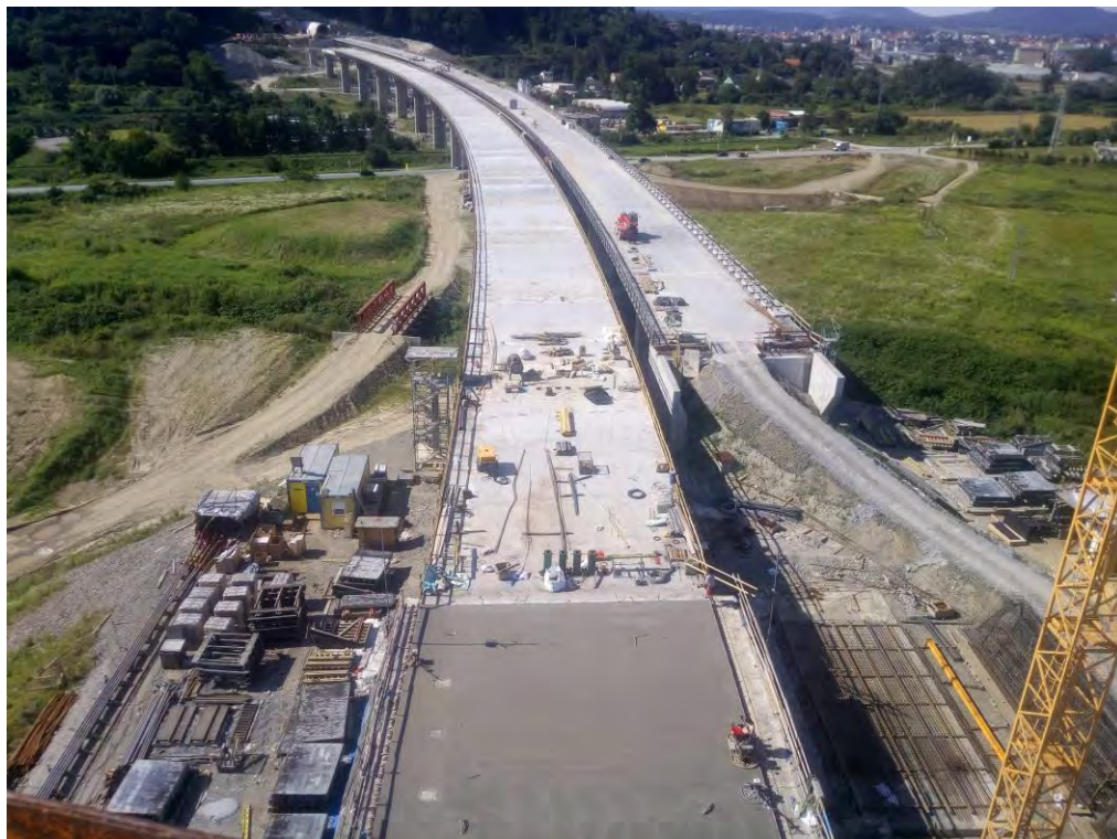
Obrázok č.4 – Ukončená betonáž vo výrobni
