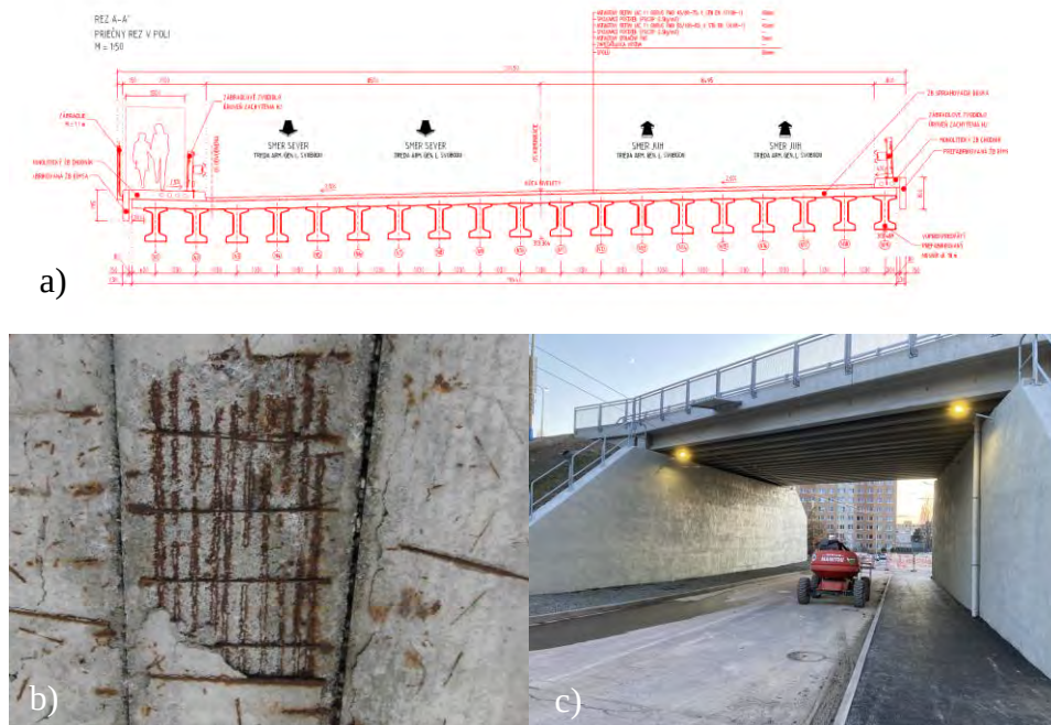
Obr. 1 – a) priečný rez rekonštruovaným mostom, b) degradácia nosníkov KA-67, c) pohľad na zrekonštruovaný most
