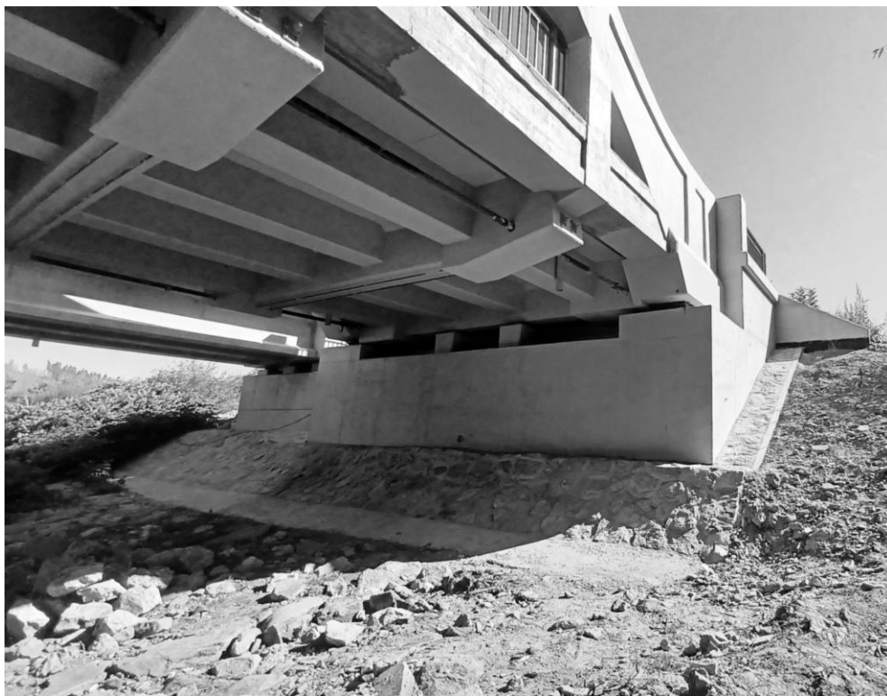
Obr. 4 Pohľad na oporu
