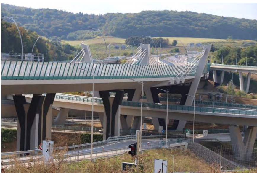
Obr. 6 Pohľad na dokončený mostný objekt 201-00
