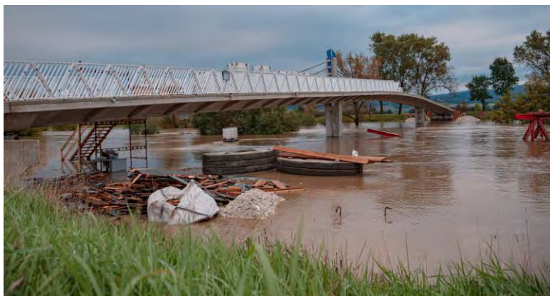
Obr. 6 Povodeň počas výstavby lávky
